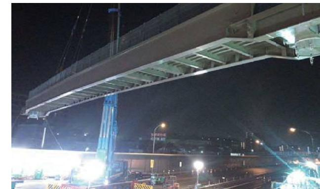
●新設鬼越歩道橋 550t吊クレーンによる一括架設
