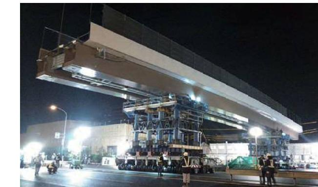
●オフランプ橋 多軸式自走台車による一括架設
