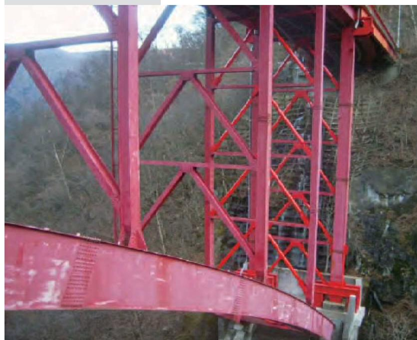
●完成状況(P2方向)ブレース・端支柱補強・ピン支承補強
