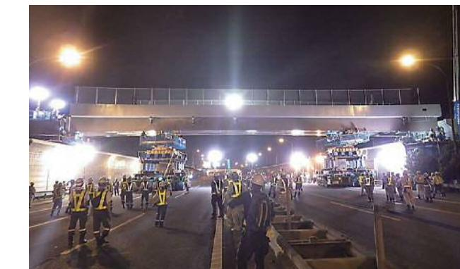
●オンランプ橋 多軸式自走台車による一括架設
