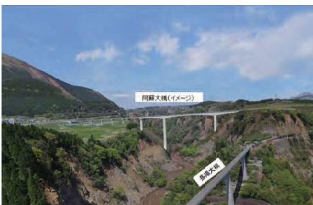
写真-5 阿蘇大橋の架設イメージ(PC3径間連続ラーメン桁橋)
