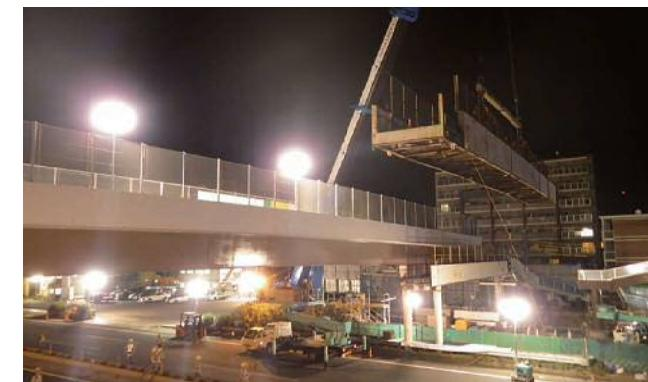
●既設鬼越歩道橋 550t吊クレーンによる一括撤去
