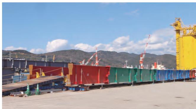
緊急仮設橋は3日以内に架設するというコンセプトで開発した仮設橋で、継手の構造に特徴があります。桁の色も赤や青に塗り分けられており、現場での作業が迅速に進むよう配慮してあります。
