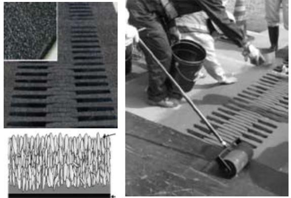
伸縮装置滑り止め材として、摩擦素子コート工法の施工を行っております。スリップ懸念のある幅広の伸縮装置やRの小さいランプ橋等、様々な場所で使用実績を伸ばしております。
