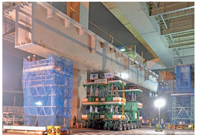
● 多軸式自走台車による主桁架設状況
