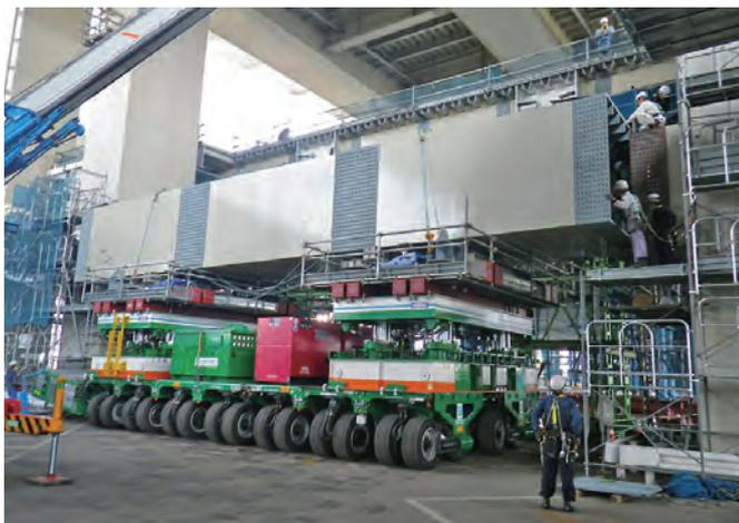
● 多軸式自走台車による横梁架設状況
