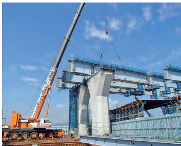
その対応として、6径間の内、隣接工区の施工ヤードと競合しない3径間分を先行架設と床版打設までを行い、架設ヒンジを設けて、施工ヤード解放後、残りの3径間を架設連結する工法に変更しました。架設ヒンジの位置と連結時期、先行床版の打ち止め位置については、後行架設部の影響を考慮して決定しました。特に架設ヒンジの連結時期については、連結前に後行架設部の床版を打設するケースと連結後に打設するケースで比較検討を行い、工程短縮に有効かつ先行打設した床版に有害な引張応力を残留させない後者を採用しました。さらに、壁高欄に鋼製型枠を採用するなど、様々な工程短縮策を講じました。
