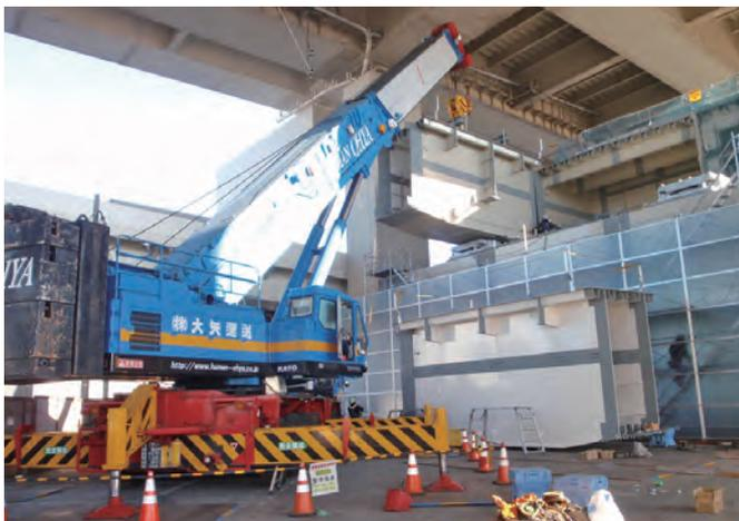
● トラッククレーンによる主桁架設状況
