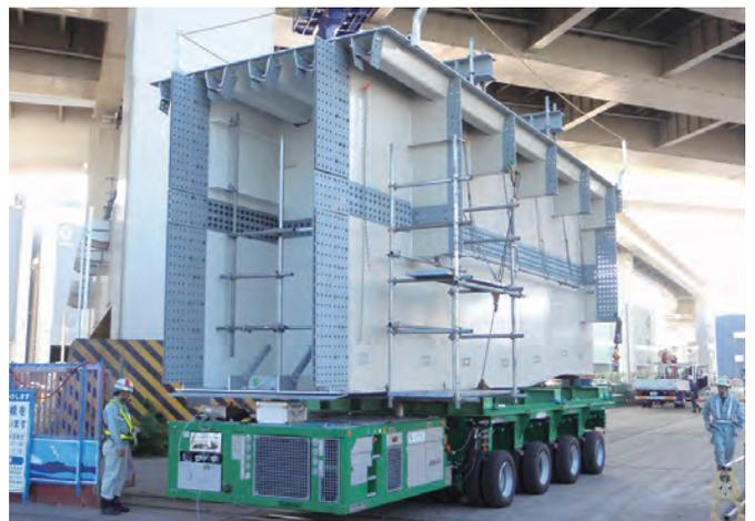
● 多軸式自走台車による主桁運搬状況
