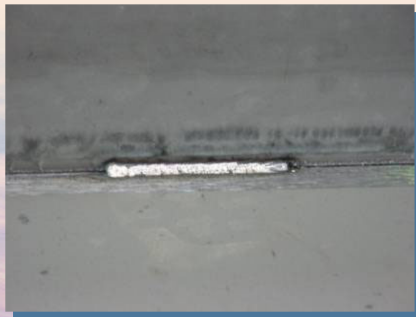
縦リブ組立装置による組立溶接
