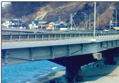
上部工補強施工例
