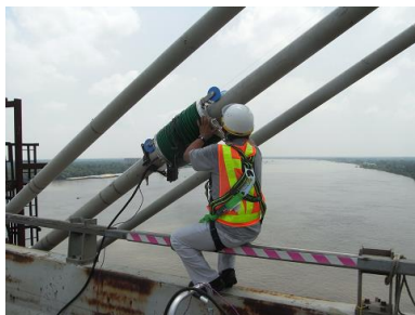
計測状況： 斜張橋斜材
