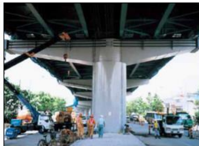
下部工補強施工例
