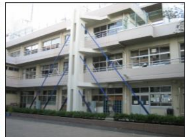
建築耐震補強施工例
