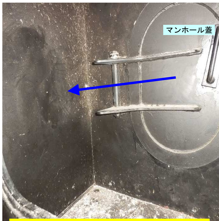
② マンホール
