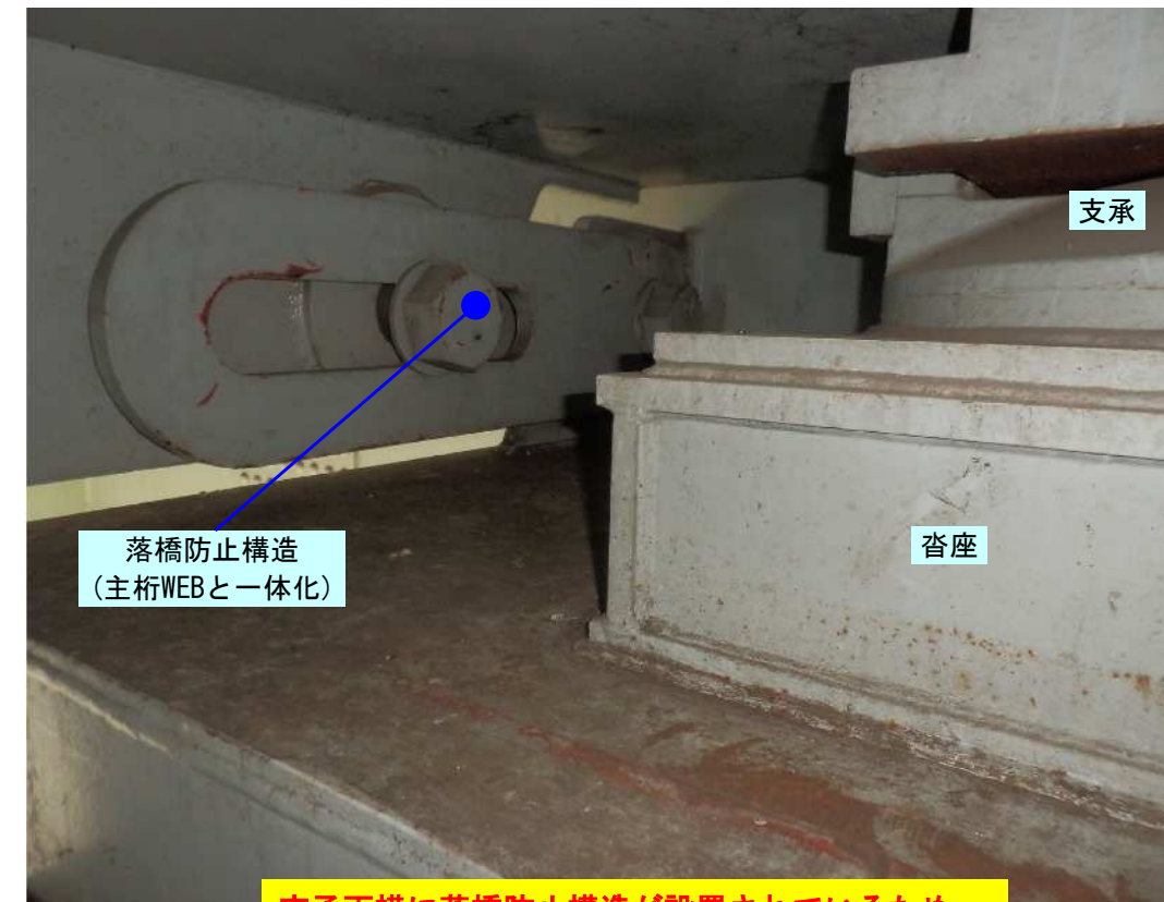
① 落橋防止構造
