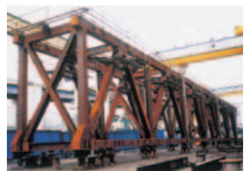
合理化トラス橋 (板橋川橋梁)
