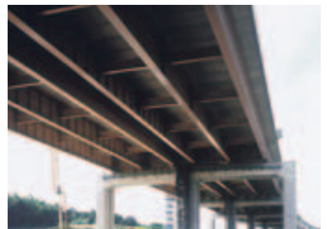
東海大府高架橋（3主桁×上下線2連）
