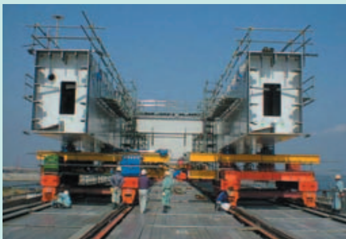
町屋川橋（員弁川橋）
