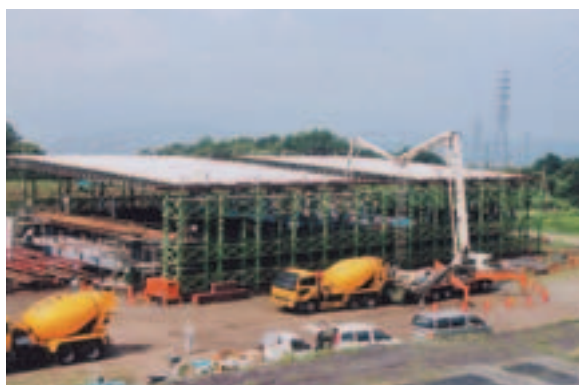
場所打ちPC床版施工確認実験
