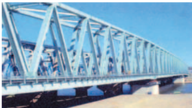
常磐新線 荒川橋梁（景観処理仕様の例）
