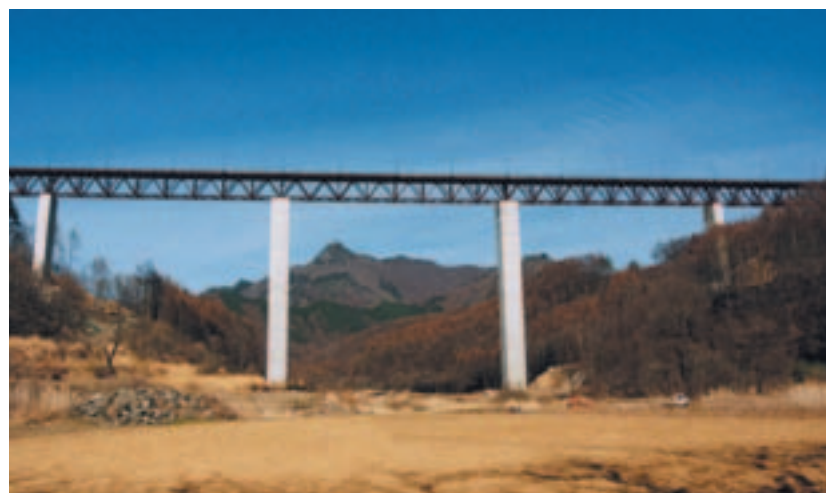
板橋川橋梁 (合成床版)
