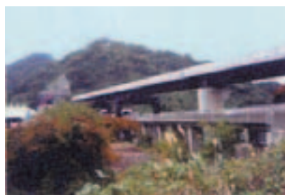
北陸道架道橋 (完成時)
