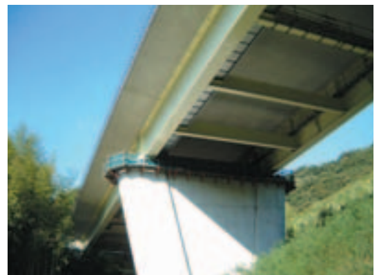
藁科川橋（床版支間11m）
