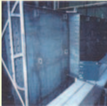
(1) 下地処理 (製品プラストSa2以上) (又は動力工具ケレン(St3以上))
