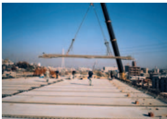
牧ノ里高架橋
