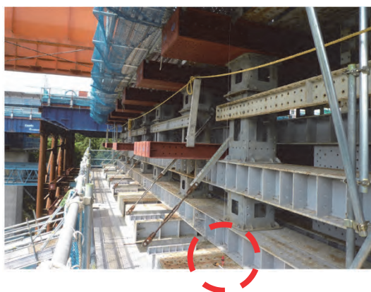
(c) 下げ振りによる計測（全景）
