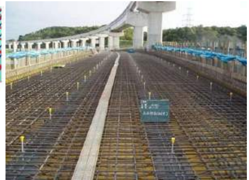
RC床版(鉄筋組立完了)
