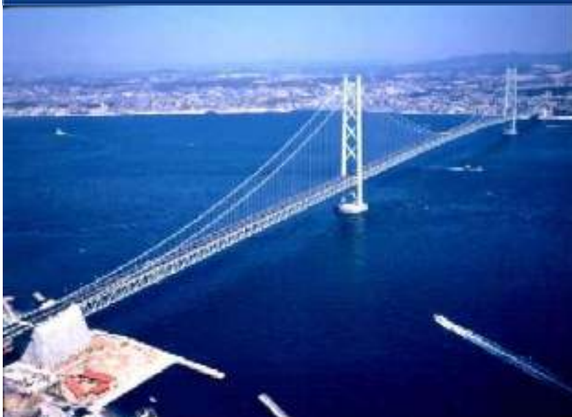
3径間2ヒンジ補剛トラス吊橋
