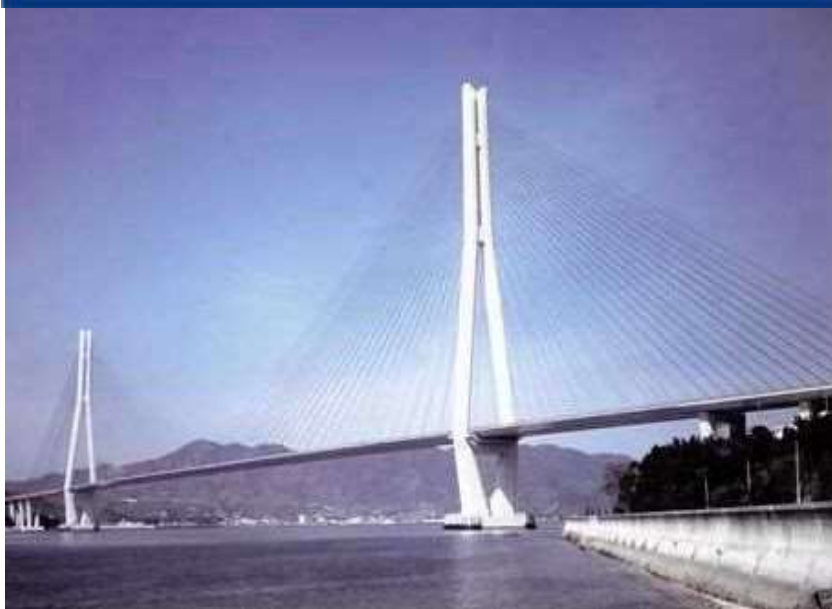
3径間連続複合箱桁斜張橋
