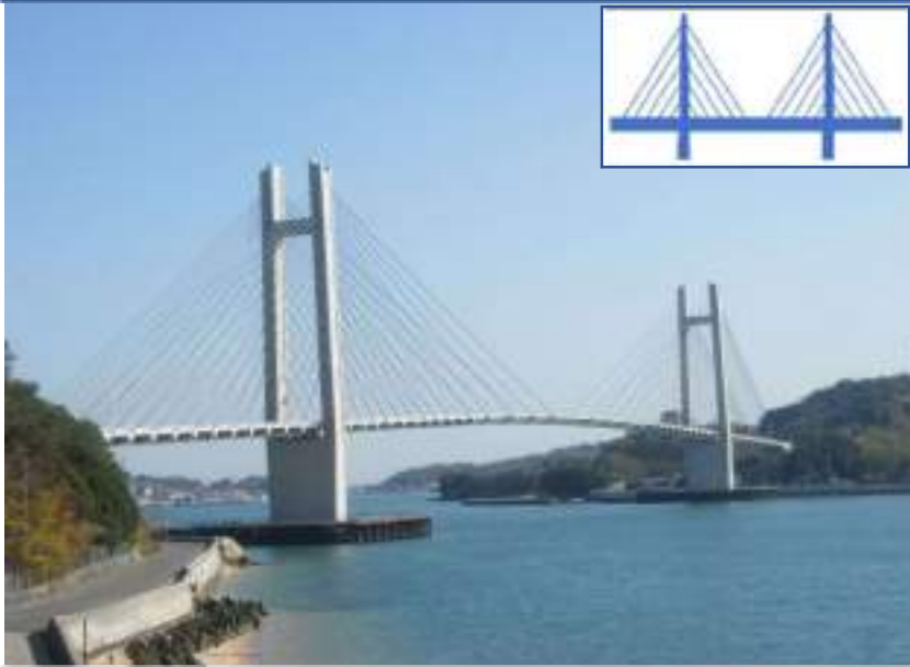
鋼・コンクリート混合斜張橋
