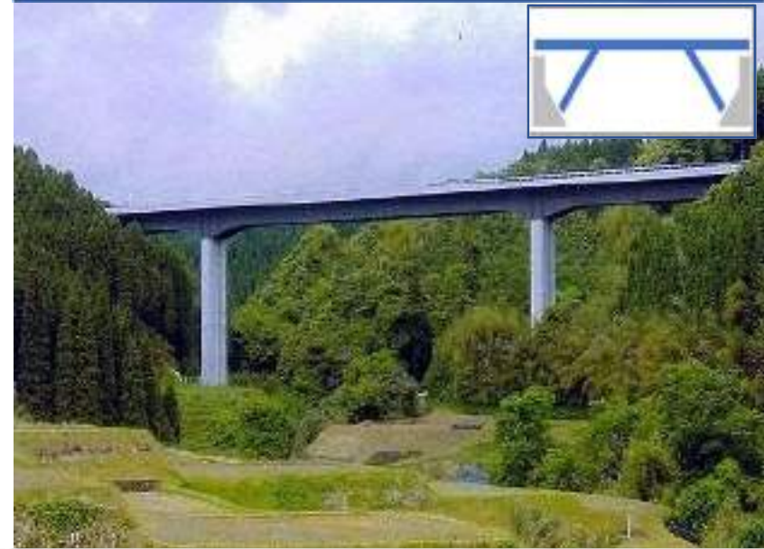
鋼・コンクリート複合ラーメン橋
