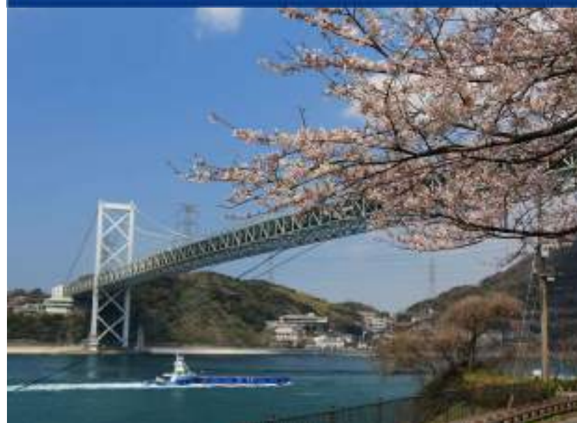
3径間2ヒンジ補剛トラス吊橋
