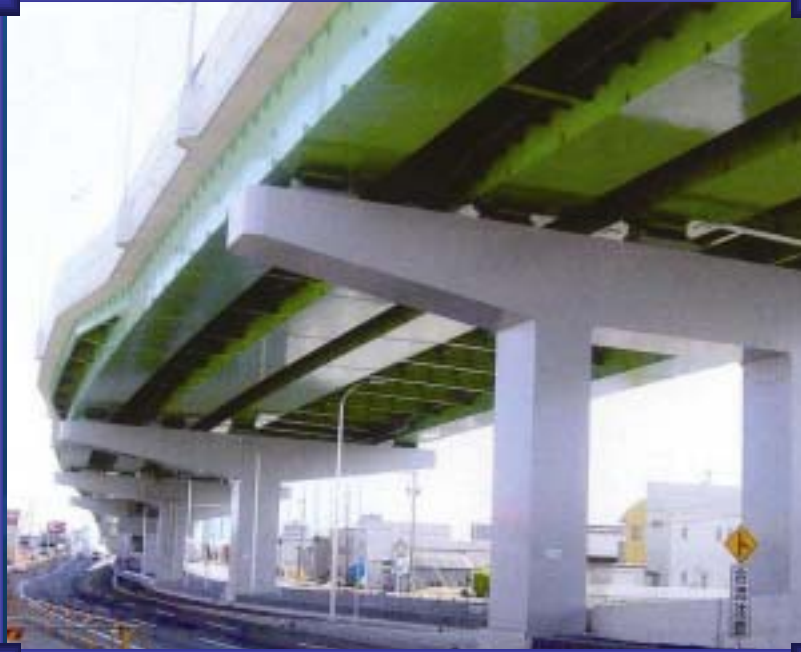
名古屋高速西春工区
