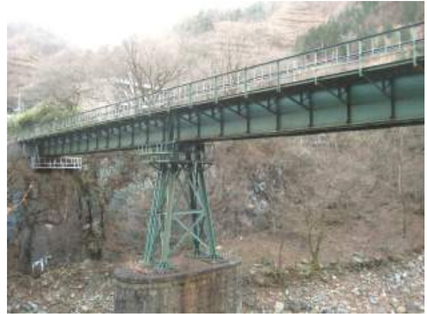
第一松木川橋梁（トレスル形式の橋脚） 栃木県日光市
