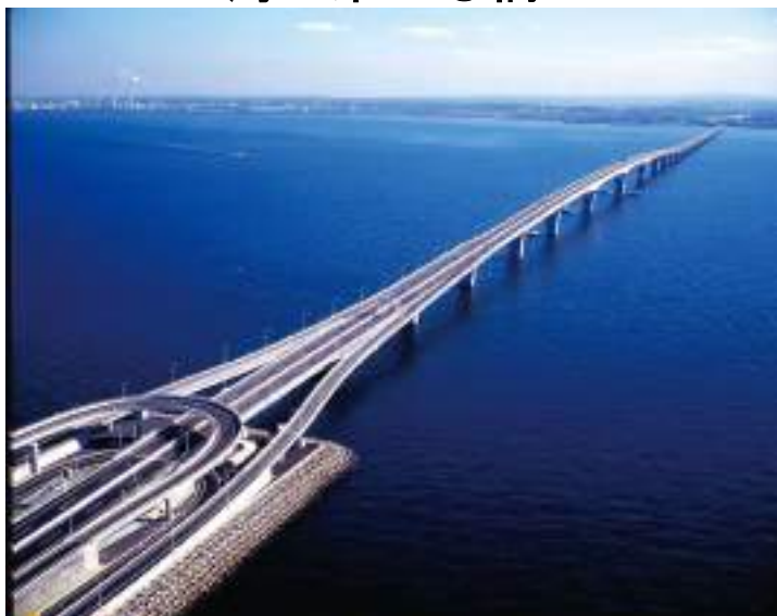
東京アクアブリッジ（桁橋）
