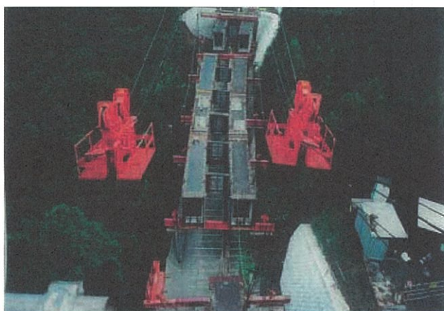
写真1-1-1 直吊り架設の状況（箱桁橋の事例）
