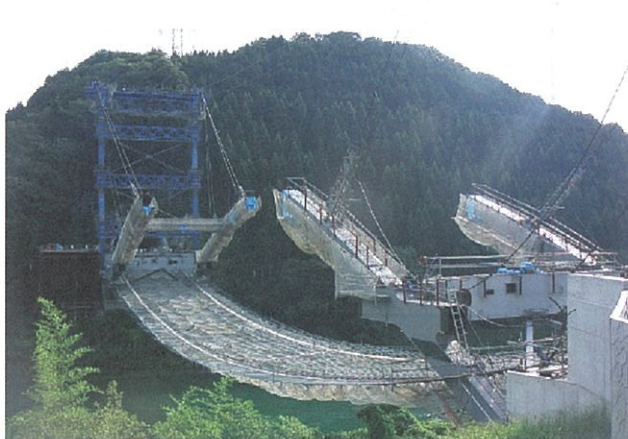
写真1-1-3 斜吊り架設の状況 （上路アーチ系橋梁の事例）
