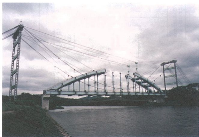
写真1-1-2 直吊り架設の状況 （下路アーチ系橋梁の事例）
