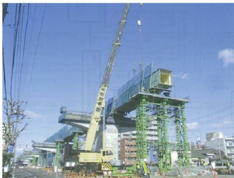
写真1-1-1 トラッククレーンベント工法の事例
