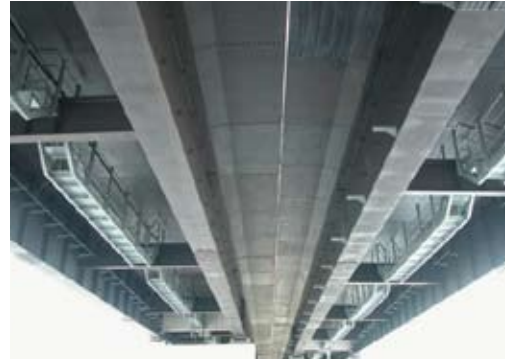
■耐候性鋼材を使用した少数 I 桁橋
