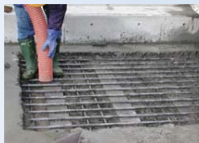
■コンクリートはつり後の状況
