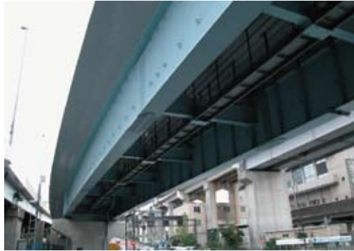
■防錆を塗装とした少数 I 桁橋
