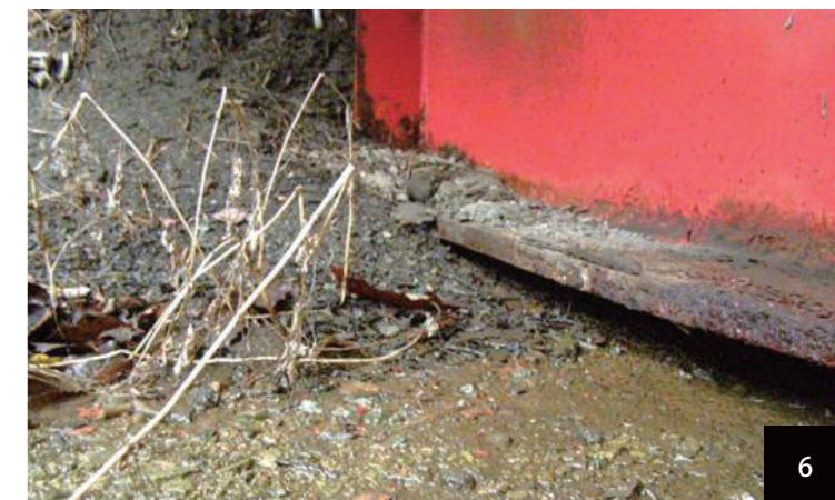
土砂の堆積および雨水による支承と桁の腐食
