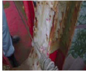
雨水の影響による支材下端の腐食
