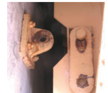
落橋防止のボルトが欠落
