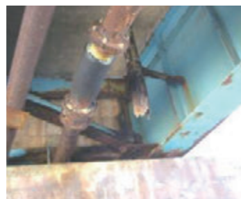
雨水の影響による排水管の欠落
