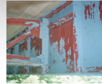
桁および対傾構の防食機能の劣化
