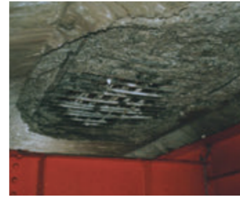
雨水の浸入による床版のひび割れ
