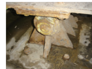
土砂の堆積および雨水による支承と桁の腐食
