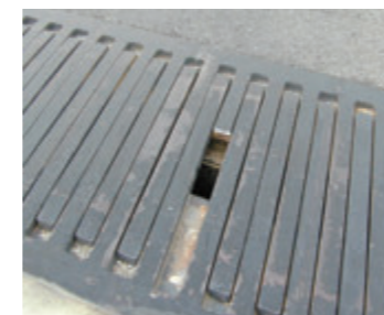
輪荷量によるフィンガーの破損
