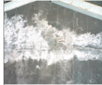
浸透した雨水が原因で発生した遊離石灰
