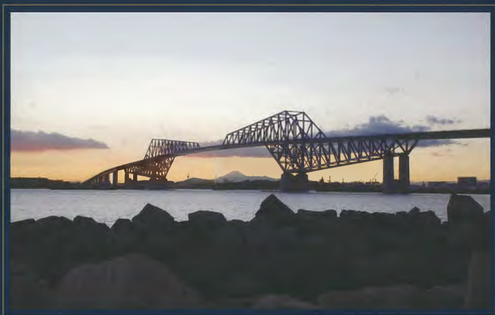
東京ゲートブリッジ
