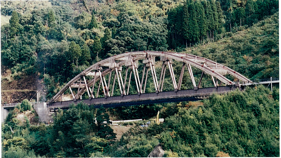
さんぼうだに とう 三方谷 2 号橋 (トラスドラムアーチ橋)
