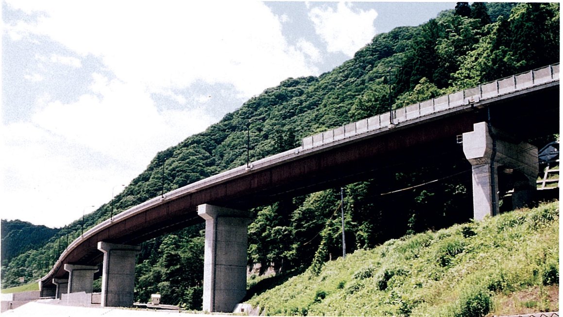
しま とう かの 島 高 架 橋 (連続箱桁橋)
