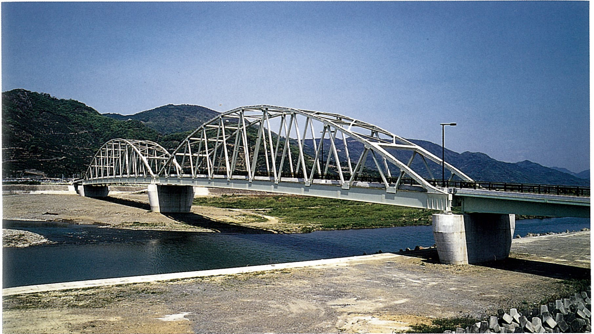
ありたひがし 有田東大橋 (トラスドランガー橋)
