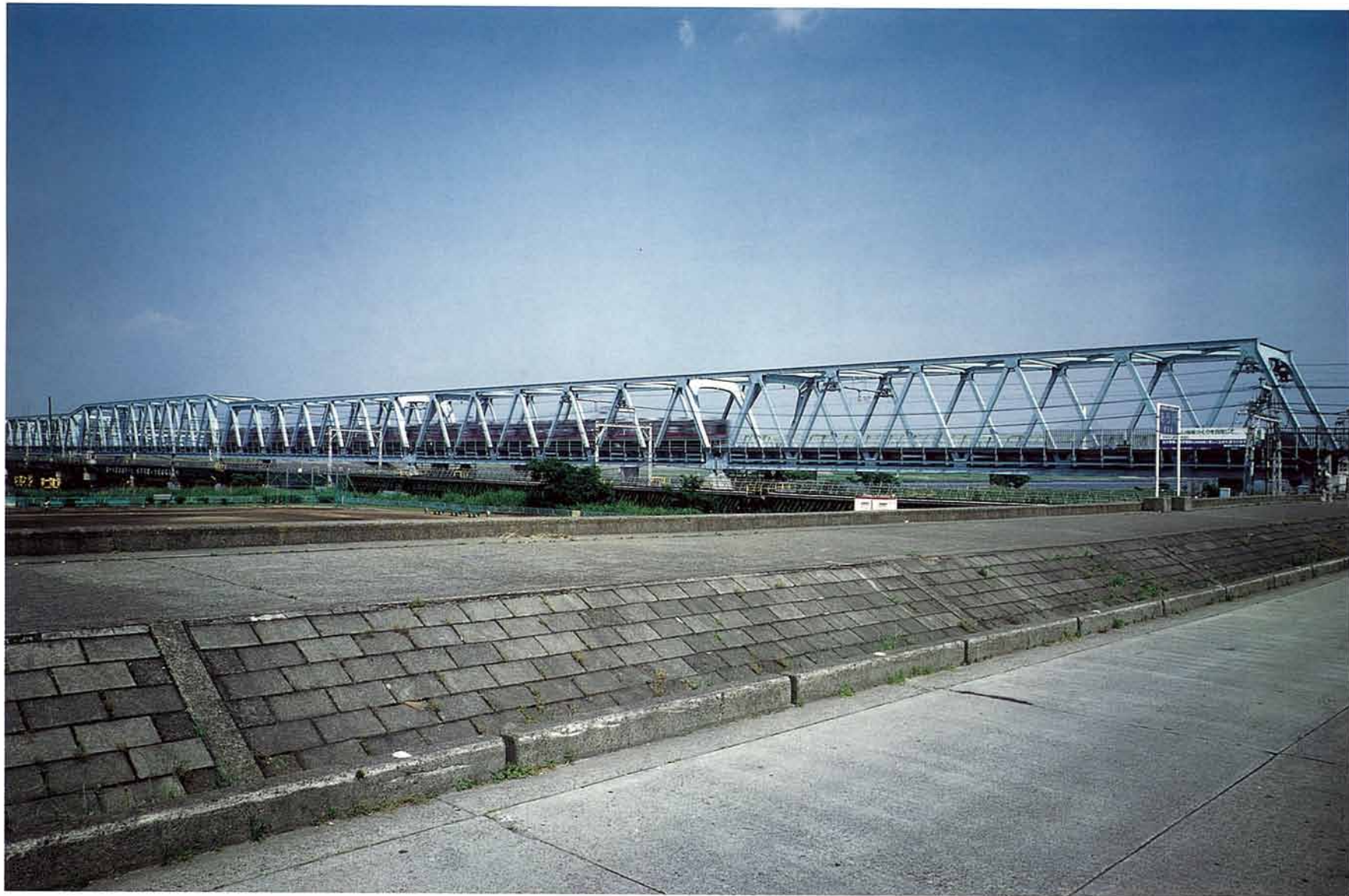
あら かわ 荒 川 橋 梁 (下路トラス橋)
