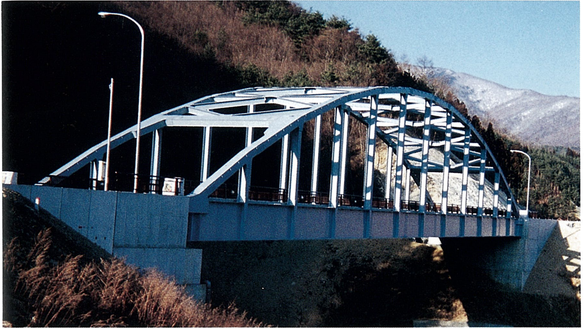
たこう 鷹生ダム4号橋 (ランガー桁橋)
