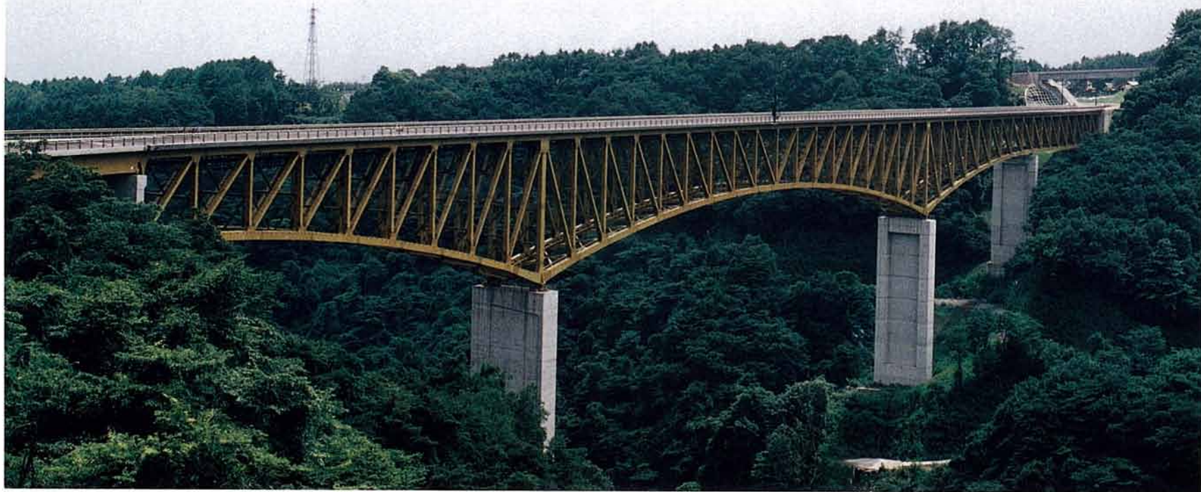
やつ が たけこうげんおお 八ヶ岳高原大橋 (連続トラス橋)
