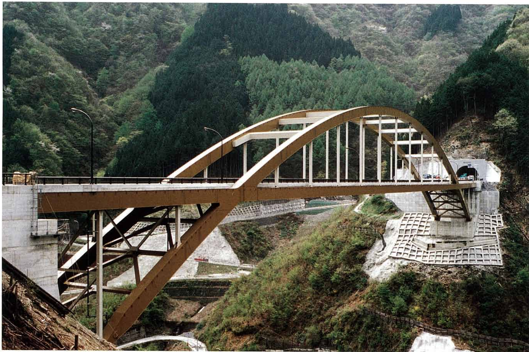
なか つか かわ おお 中 津 川 大 橋 (ローゼ橋)
