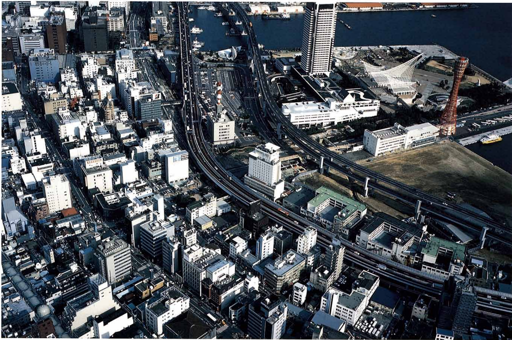
ごうこう べ せんふつきゅう 3号神戸線復旧第16工区 (ラーメン橋)
