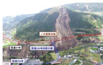
(阿蘇大橋地区の被災状況)
