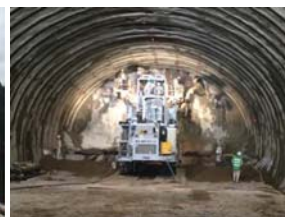
(二重峠トンネル・大津側・本坑)
