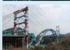
新天門大橋 (天草1号橋横)
