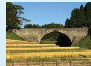
通潤橋(山都町)
