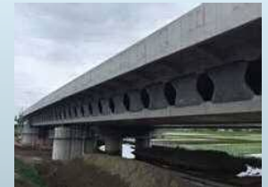
桶川橋梁 (圏央道)
