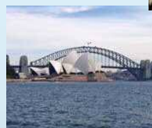
ハーバー・ブリッジ 1932年 (シドニー)
