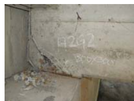
主桁端部の座屈損傷
