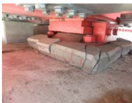
台座コンクリート損傷
