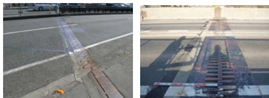
主桁端部の座屈損傷
