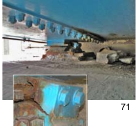
支承サイドブロック損傷
