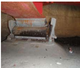
鋼製支承(ローラ沓)損傷
