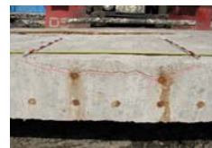
撤去床版で上縁鉄筋から床版上縁に向かってひび割れが発生していることもある 19
