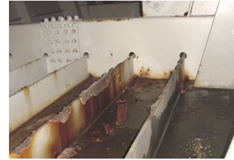
箱桁内部の管継手部漏水・滞水
