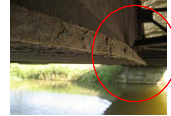
桁下空間狭小箇所、橋詰め付近の腐食
