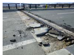
伸縮装置部の段差
