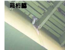
床版と桁の境界排水取付部漏水
