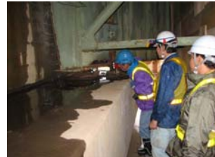
パラベットからの漏水が橋座に滞水
