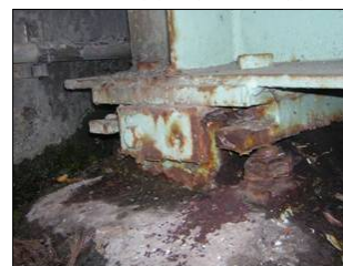
桁端部(伸縮装置部)
