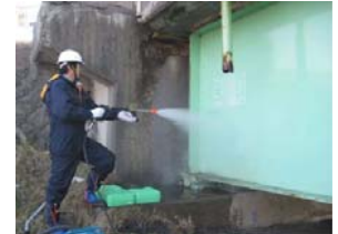
桁洗浄における塩分量判定基準 50 mg/m 2 (塗装・防食便覧)を満足するには2~3回洗浄必要
