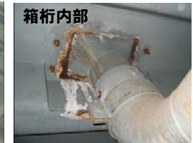
床版と桁の境界排水取付部漏水
