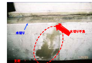
・床版ひびわれからの漏水, 防水層の未設置・破損
