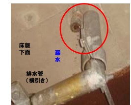
排水管との接続不良
