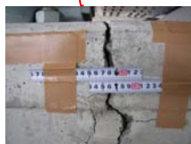
最大ひびわれ幅 0.0mm
