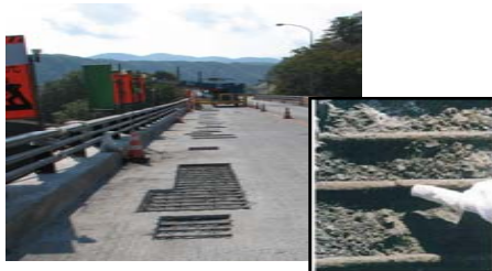
床版の浮き撤去では走行軌跡に沿って損傷している
