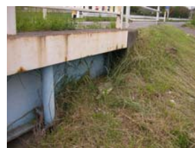
桁端部土砂堆積による障害
