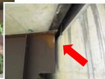
伸縮装置の漏水による腐食
