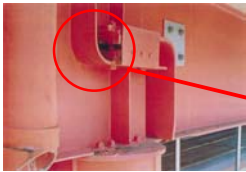
ソールプレートに沿ってウェブにまで達している
