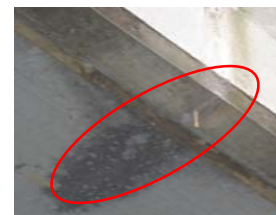
・床版ひびわれからの漏水, 防水層の未設置・破損
