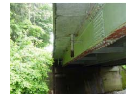
落橋防止システム設置による障害
