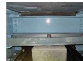
落橋防止システム設置による障害
