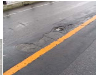
舗装面にも損傷が見られる
