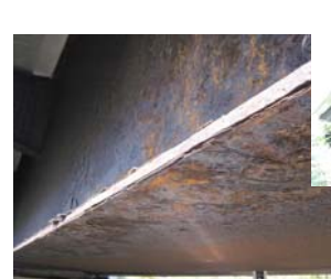
路面排水管付近の腐食
