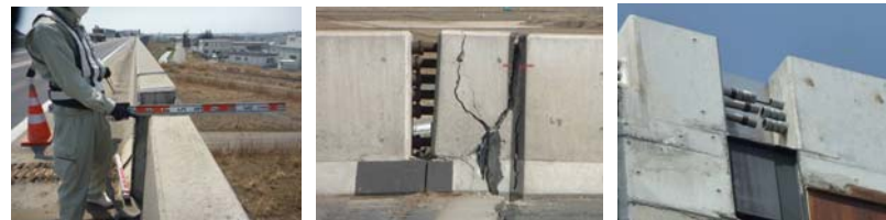
翼壁の破損・段差
