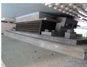
ゴム支承の残留変形
