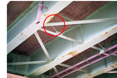
排水管との接続不良
