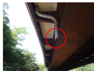
伸縮装置の漏水による腐食
