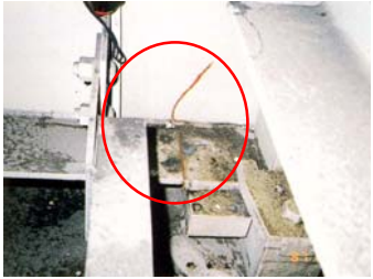
ソールプレートに沿ってウェブにまで達している
