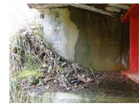
桁端部土砂堆積による障害
