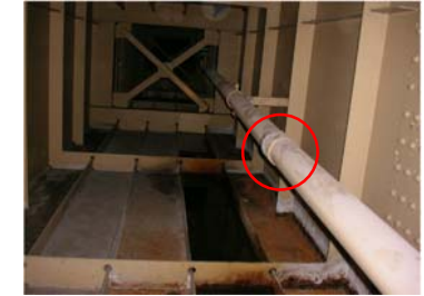
床版と桁の境界排水取付部漏水
