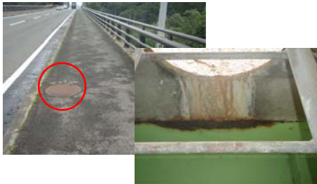
歩道内点検口からの漏水
