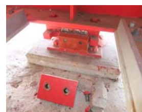
支承サイドブロック損傷
