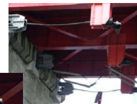
落橋防止装置損傷
