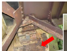
伸縮装置の漏水による腐食
