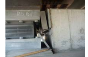
緩衝ゴムの損傷
