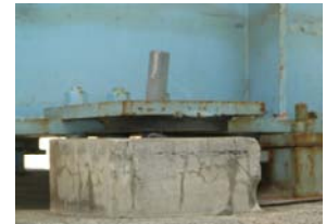
変位制限装置バーの変形
