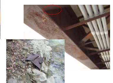
床版水抜きパイプ付近の腐食
