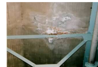
・床版ひびわれからの漏水, 防水層の未設置・破損
