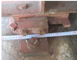
移動制限装置の破断
