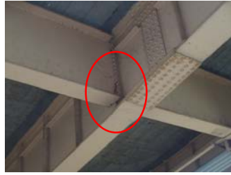
斜角のある鋼単純合成桁の横桁取り付け部
