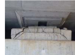
変位制限装置の損傷
