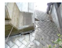
ブロック積みの破損・沈下
