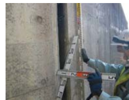
連続擁壁の傾き、空き
