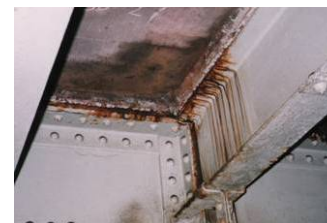
・床版ひびわれからの漏水, 防水層の未設置・破損
