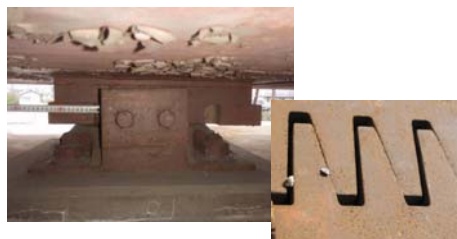
支承の移動量、伸縮継ぎ手の遊間
