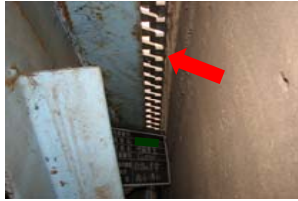
(降雨時)伸縮装置からの雨水
