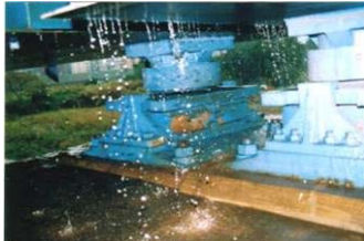
(降雨時)伸縮装置からの雨水
