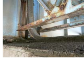
パラベットからの漏水が橋座に滞水
