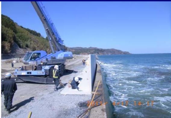
・北上川の緊急復旧状況(パラベット設置)(宮城県石巻市月浜地先)
