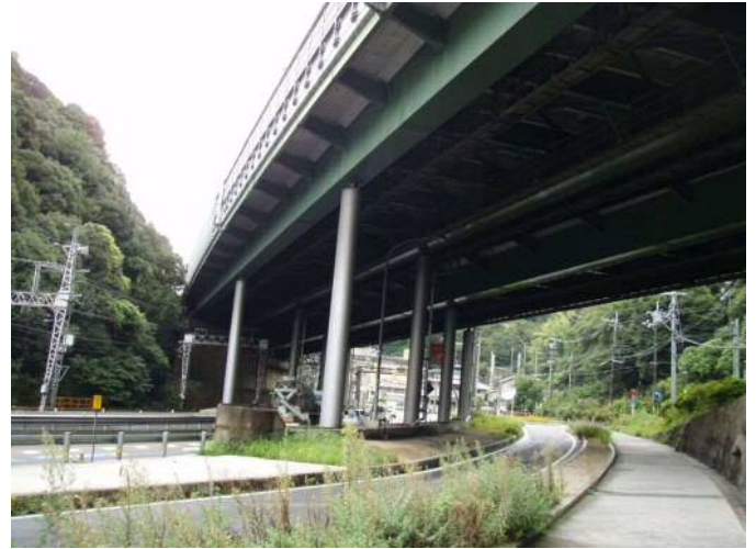
写真-1 追分橋（施工前）
