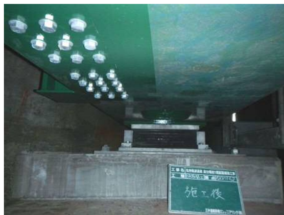
写真-16 端支点支承取り替え後
