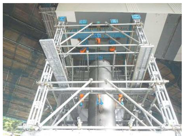
写真-13 既設ロッキング橋脚の支持
