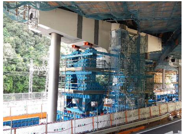
写真-10 鋼製梁ジャッキアップ
