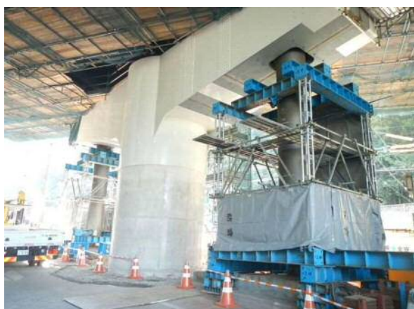
写真-12 既設ロッキング橋脚の撤去
