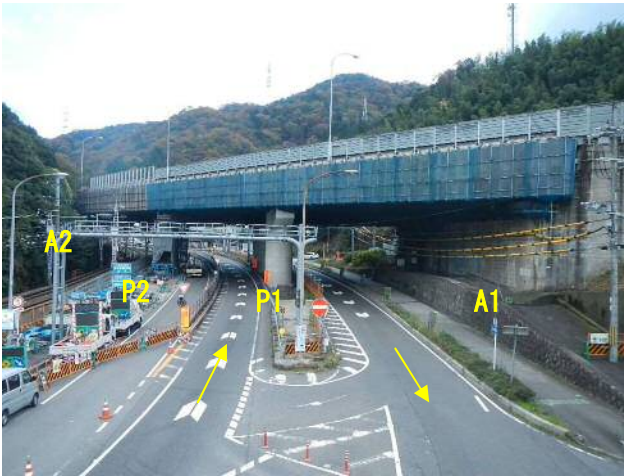
写真-4 P2 橋脚施工時状況
