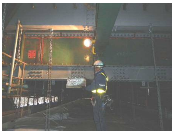
写真-14 横桁補強
