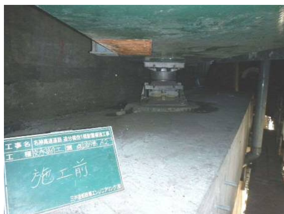
写真-15 端支点支承取り替え前
