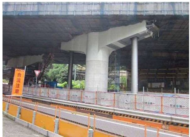
写真-11 新設橋脚完成
