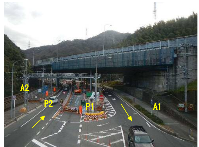
写真-3 P1 橋脚施工時状況
