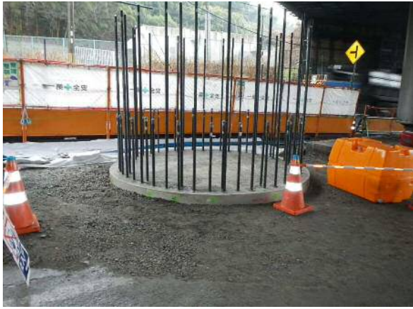
写真-5 基礎工及びRC柱1次施工完了
