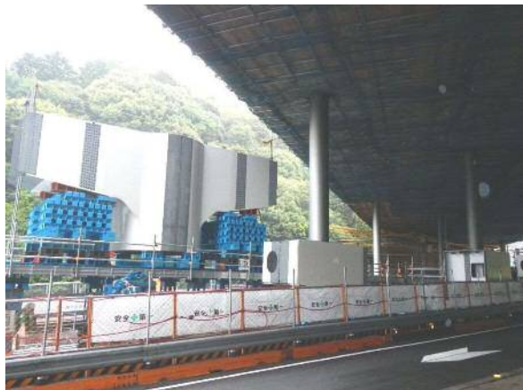
写真-7 鋼製梁部材（移動前）
