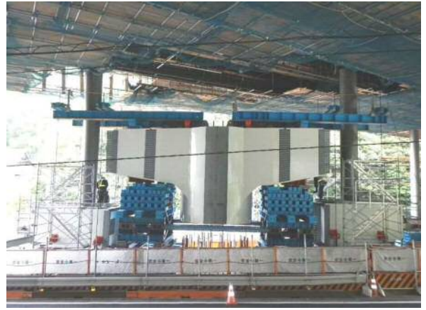
写真-9 鋼製梁一体化・吊上げ
