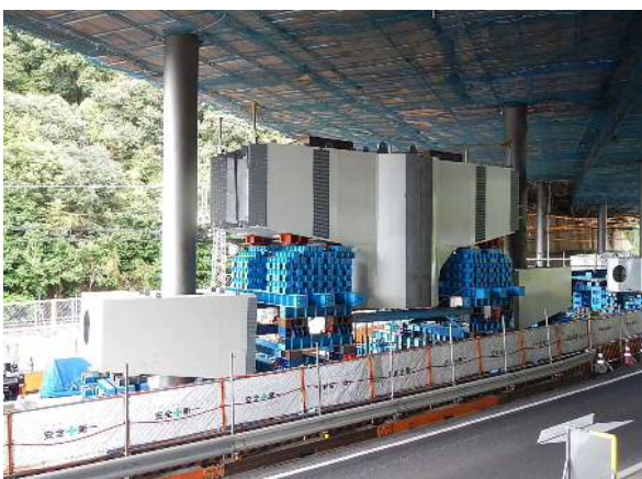
写真-8 鋼製梁部材（移動後）
