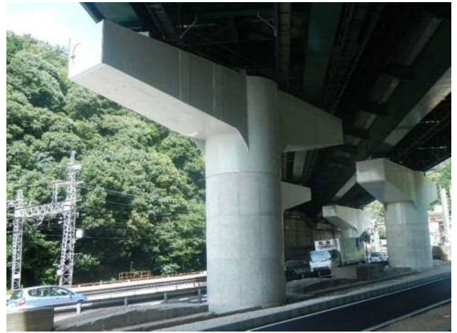
写真-2 追分橋（施工後）
