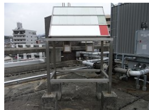
写真-3 中国技術事務所屋上暴露外観
