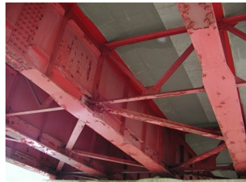
写真-2 塗装後16年経過したフタル酸樹脂塗装
