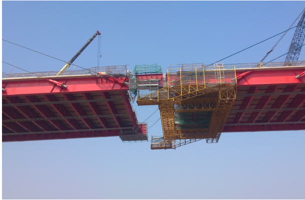
写真-12 閉合作業(桁の架設)
