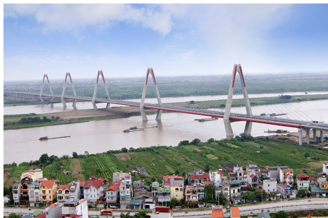
写真-1 ニャットタン橋 Main Bridge 全景
