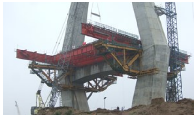
写真-4 鋼桁の架設
