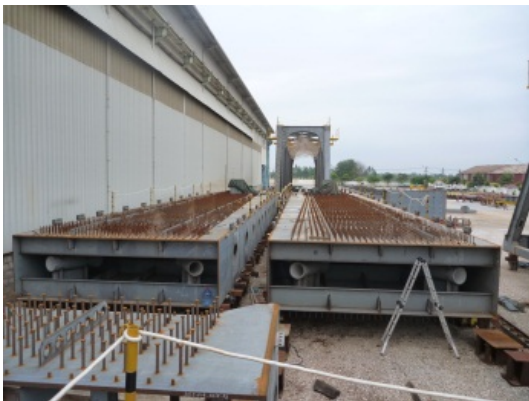
写真-3 水平全体仮組
