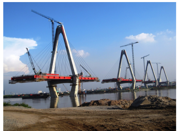
写真-8 バランシング張出し架設
