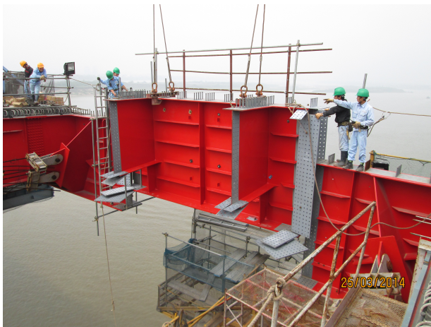
写真-13 閉合作業(桁の落とし込み)
