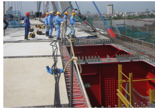
写真-7 ケーブル架設(桁側)
