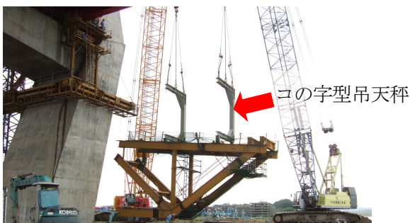
写真-5 斜ベントの撤去
