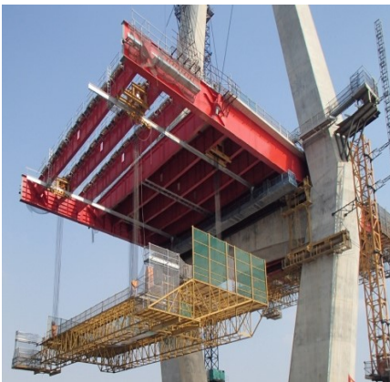
写真-6 移動防護工設備の設置
