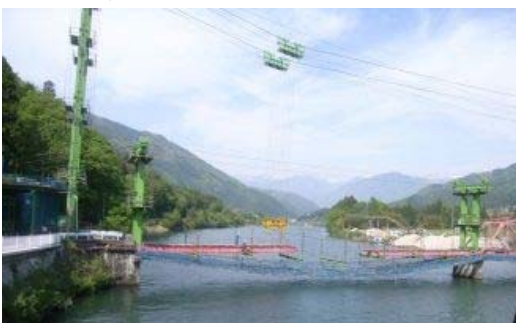
写真-3 ケーブルエレクション直吊作業状況
