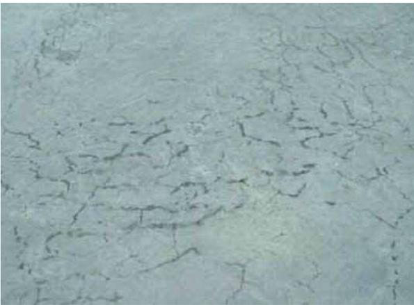
写真-11 プラスチック収縮ひび割れ
