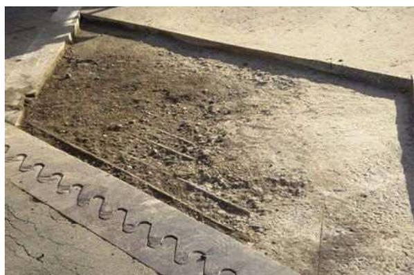
写真-5 凍害による劣化事例<sup>2)</sup>
