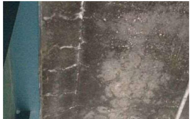
写真-2 凍結防止剤散布環境下でのASRによるひび割れ<sup>1)</sup>
