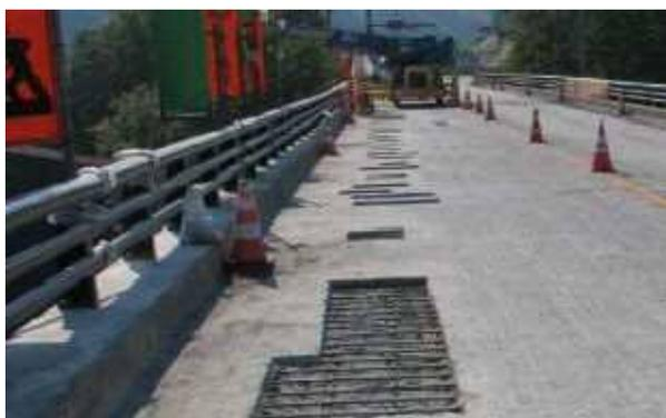
写真-3 走行車両の軌跡に沿ったコンクリートの浮き
