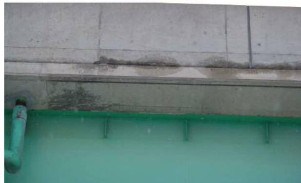
写真-7 床版と地覆の打継目からの漏水
