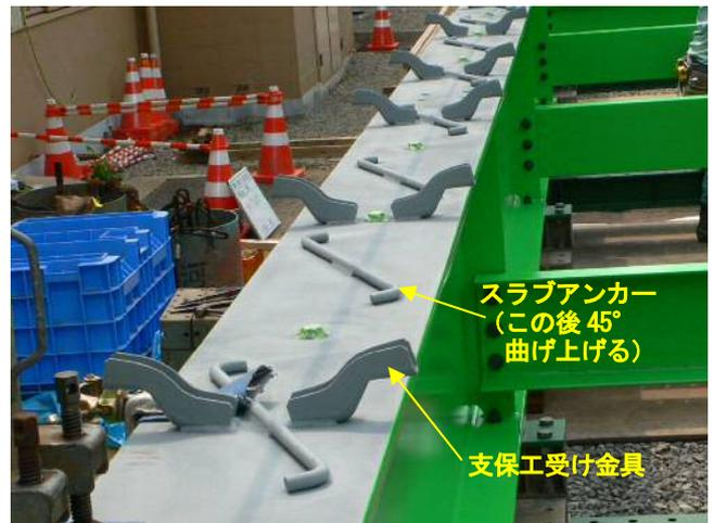
写真-14 支保工受け金具とスラブアンカー
