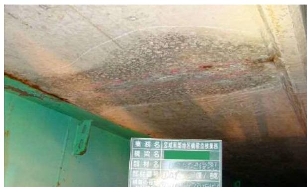
写真-6 床版打継目からの漏水
