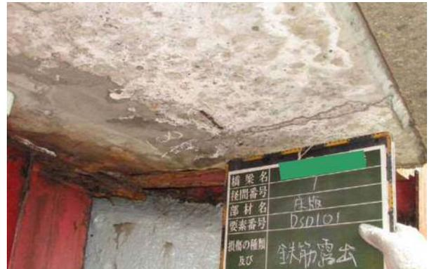
写真-1 凍結防止剤散布環境下での塩害による鉄筋腐食とひび割れ
