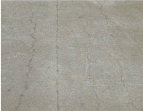
写真-10 沈下ひび割れ
