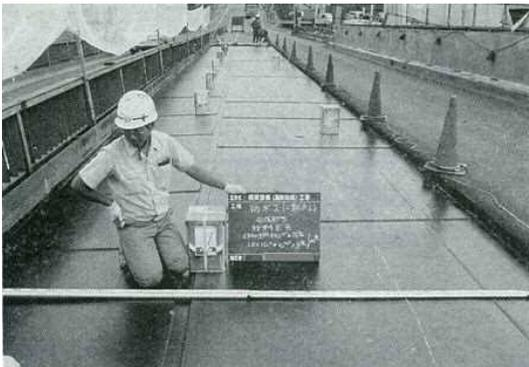
写真-10 D橋床版取替え工事<sup>6)</sup>
