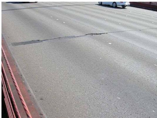
写真-23 舗装の劣化
