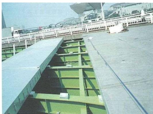
写真-2 A橋 床取替え工事<sup>3)</sup>
