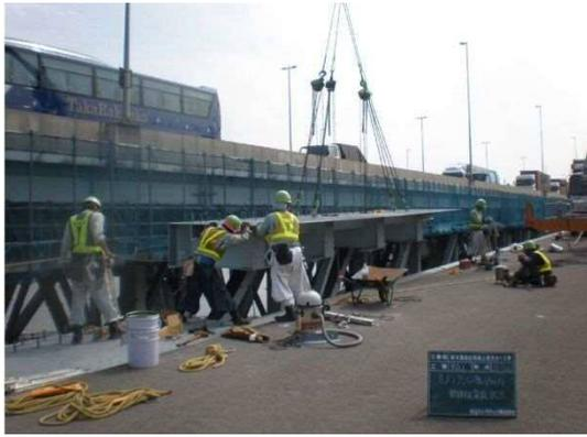
写真-21 I 橋床版拡幅工事
