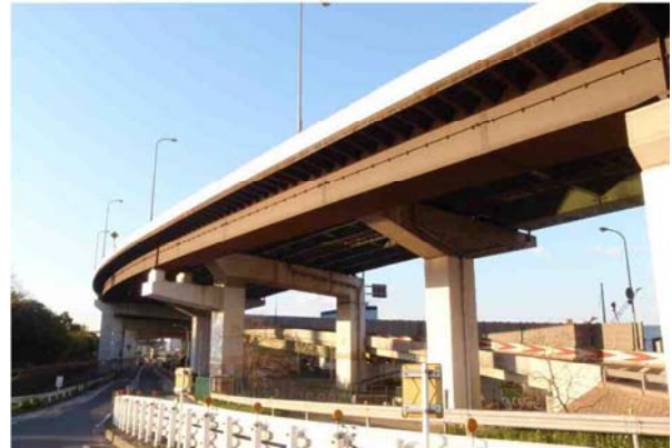
写真-2 【施工前】入路ランプ橋
