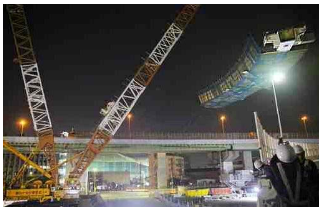
写真-14 800tf クローラクレーン大ブロック架設
