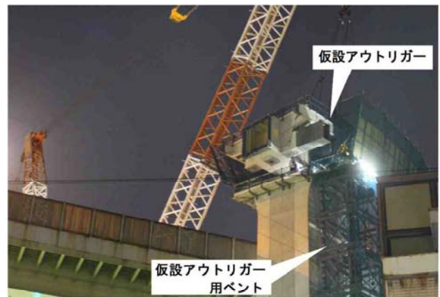
写真-13 仮設アウトリガーによる負反力対策
