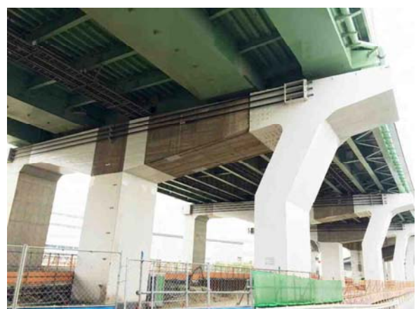
写真-9 既設橋脚横梁との連結（PCケーブル緊張）
