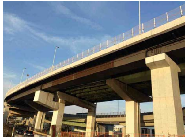
写真-3 【施工後】再利用されたランプ橋
