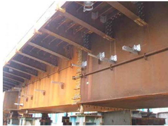
写真-7 仮組立状況（右側が再利用桁）
