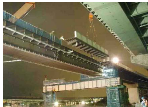
写真-6 既設入路ランプ橋の解体
