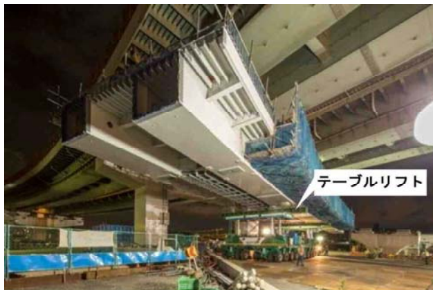
写真-12 多軸式特殊台車による大ブロック架設
