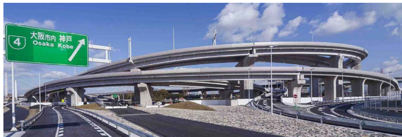
写真-15 三宝ジャンクション全景（鋼桁とコンクリート桁の連続性を考慮した景観設計）
