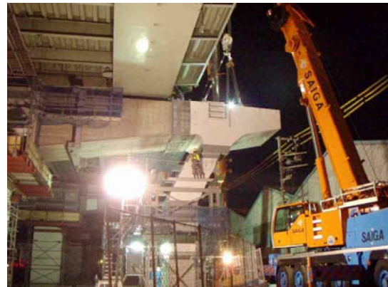
写真-8 鋼製橋脚横梁の架設状況
