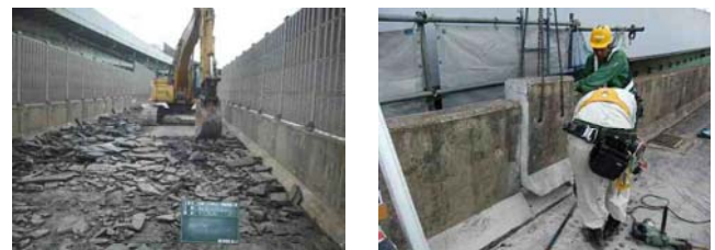
写真-5 舗装撤去・壁高欄コンクリート撤去
