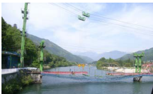
写真-3 ケーブルエレクション直吊り作業状況
