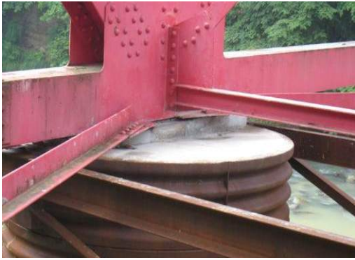
写真-35 ライナープレートにコンクリート 充填したベントによる段差防止措置
