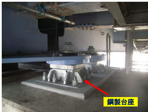
写真-58 アンカーバーによる本復旧(2)
