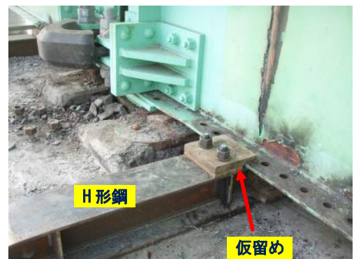
写真-49 横移動後の仮支持状況
