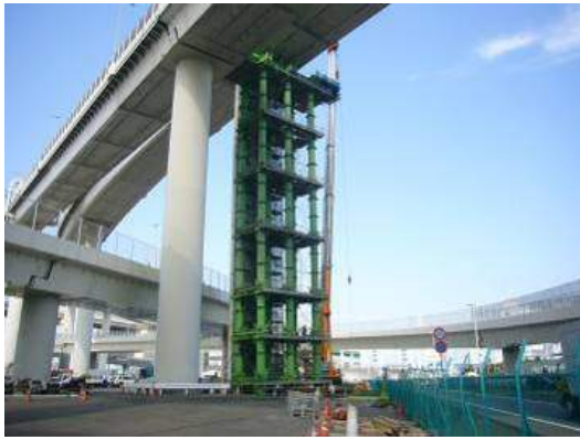
写真-20 ベント設置状況
