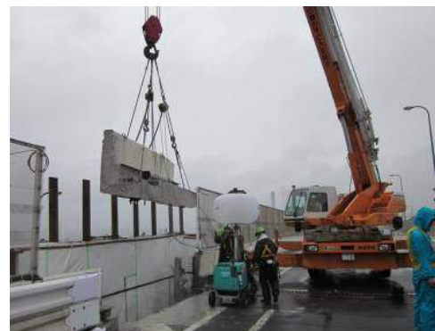
写真-23 壁高欄ブロック撤去状況
