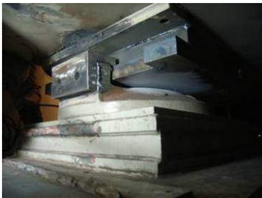
写真-22 仮上沓設置状況
