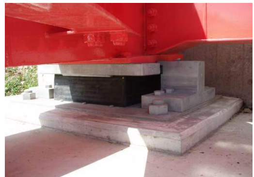
写真-41 支承取替後の状況
