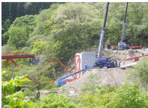
写真-39 トラス部材の架設状況
