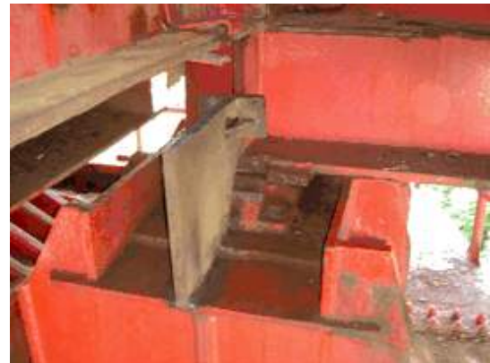
写真-9 橋軸直角方向のストッパー
