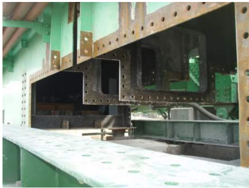
写真-52 主桁切断状況
