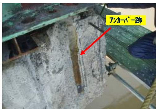
写真-44 アンカーバーで破壊された橋脚先端部
