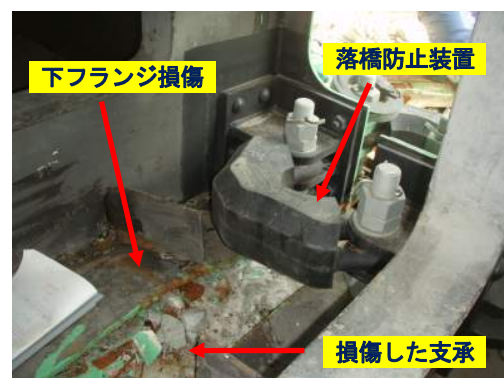
写真-45 箱桁下フランジの損傷状況
