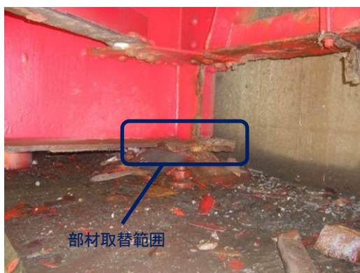
写真-12 橋台部の支承の破損状況および主桁下フランジの腐食状況
