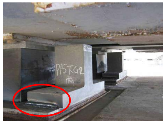
写真-56 現場溶接による応急対応
