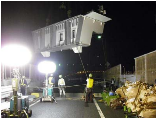
写真-28 新設桁の架設状況
