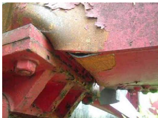
写真-33 下弦材支点近傍の損傷状況
