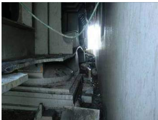
写真-16 支承および主桁の損傷状況
