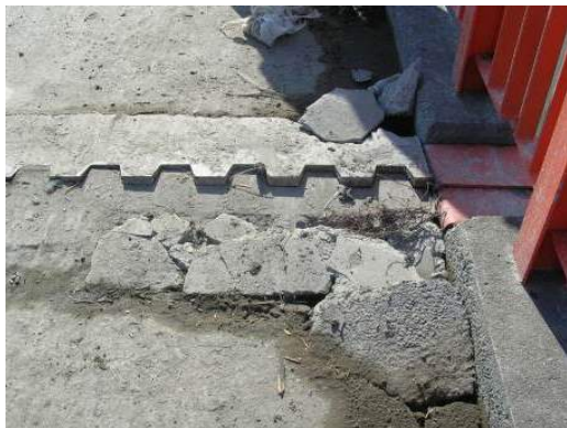
写真-59 伸縮装置損傷状況
