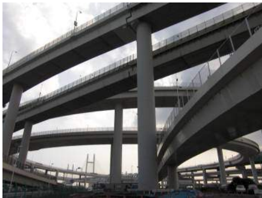
写真-15 ゲルバー部全景
