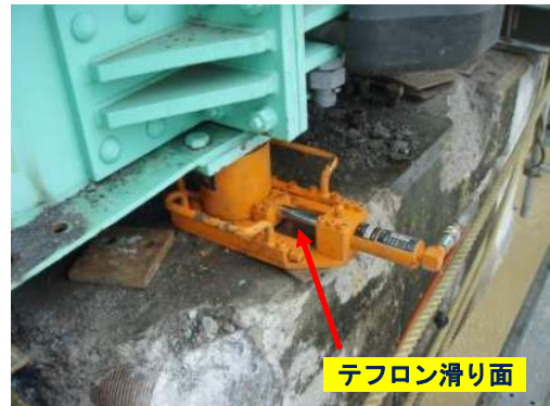
写真-48 水平ジャッキによる横移動状況
