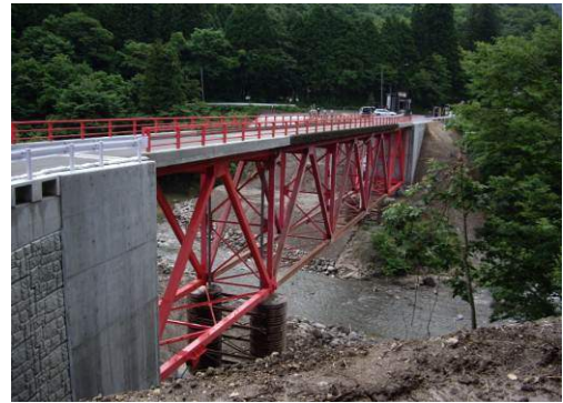
写真-40 トラス部材の架設完了状況
