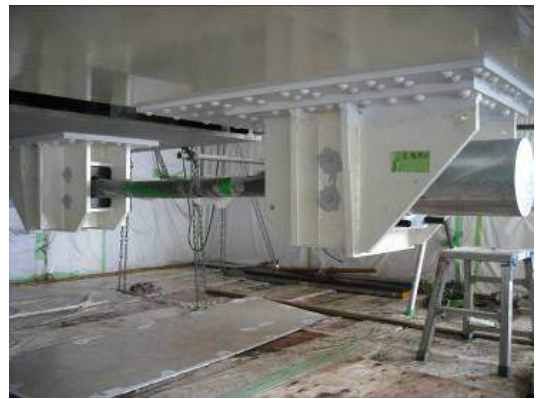
写真-30 新規設置した落橋防止装置
