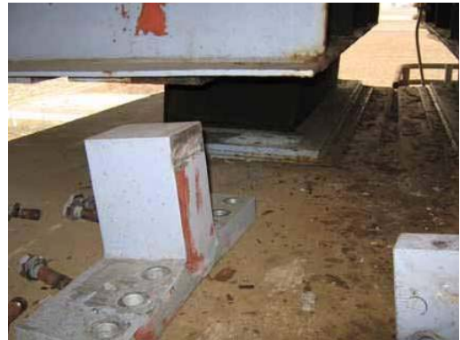
写真-55 サイドブロック損傷状況
