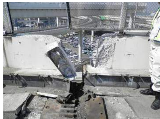
写真-18 壁高欄の損傷状況
