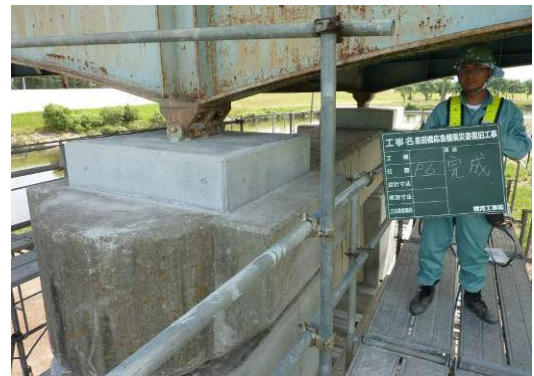
写真-66 下沓巻立コンクリート打設完了後
