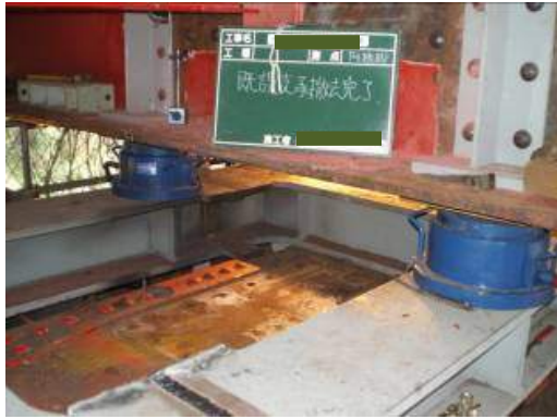
写真-10 中間橋脚部のジャッキアップ状況
