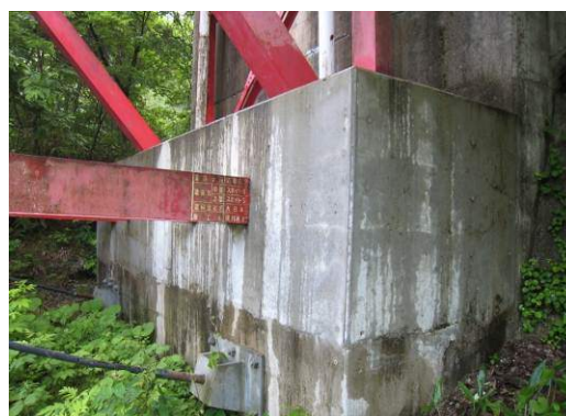
写真-34 支点部 RC 巻立による応急対応
