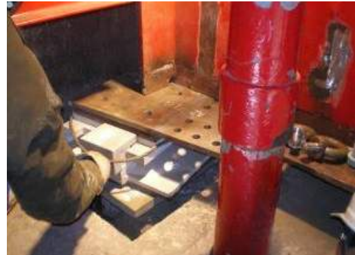
写真-13 主桁下フランジの併用継手
