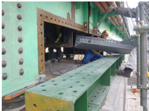
写真-53 部材取込状況
