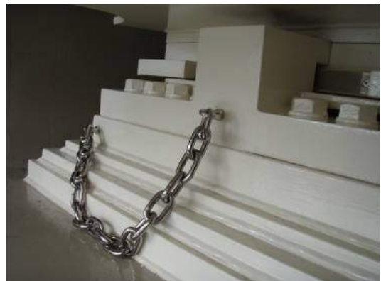
写真-31 支承サイドブロックの落下防止チェーン
