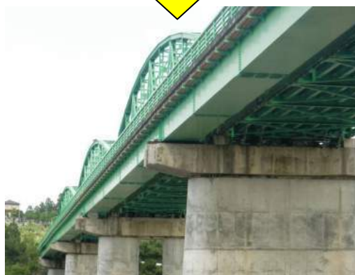
写真-50 横移動前後の全景
