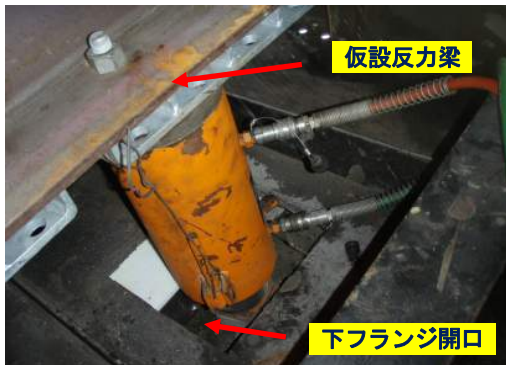
写真-46 ジャッキアップ設備
