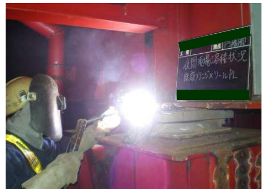
写真-14 現場溶接作業状況
