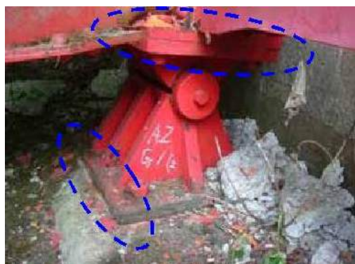
写真-32 支承の損傷状況
