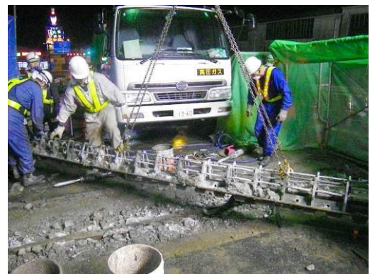
写真-62 既設伸縮装置撤去状況 (本復旧)
