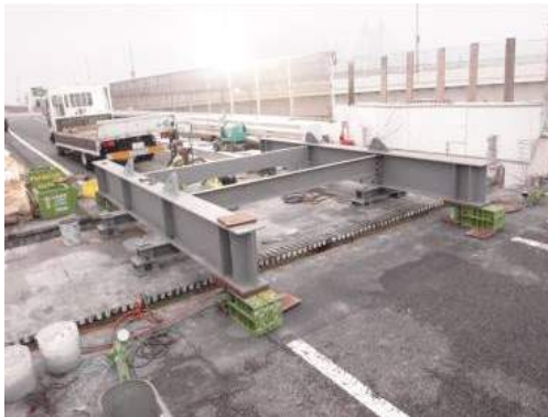
写真-24 仮支持梁
