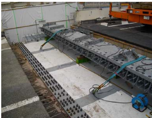
写真-29 伸縮装置の設置状況
