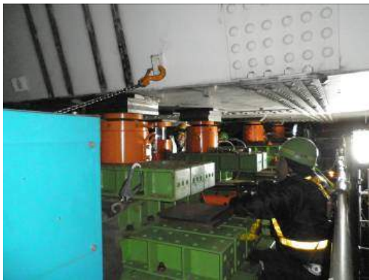
写真-21 ジャッキアップ状況
