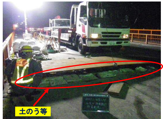
写真-60 高さ調整状況 (応急対応)
