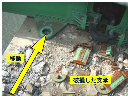
写真-42 橋脚上の損傷状況
