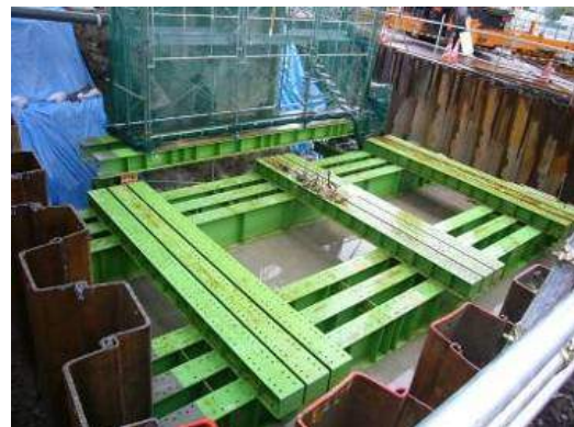
写真-19 ベント基礎施工状況
