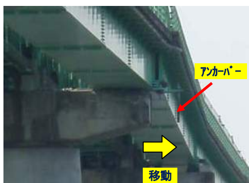
写真-43 主桁横移動の状況
