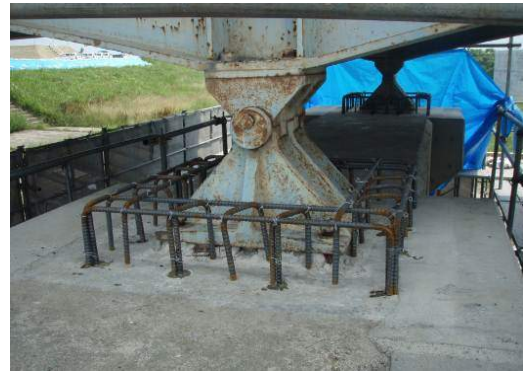
写真-65 差し筋配筋状況
