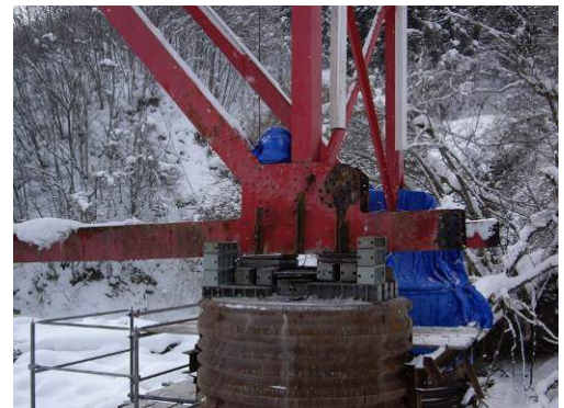
写真-38 仮支点部
