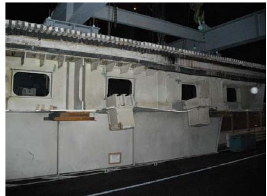
写真-26 撤去した損傷桁(ゲルバー上側)
