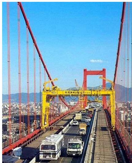
写真-20 H橋床版取替え工事
