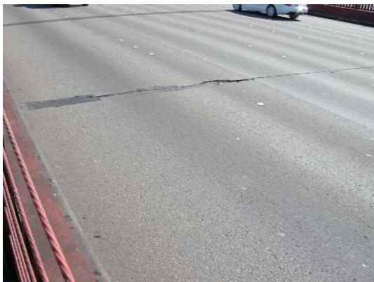
写真-23 舗装の劣化
