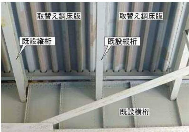
写真-37 Bronx トラス橋の取替え鋼床版構造
