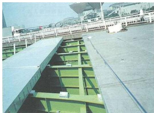
写真-2 A橋 床取替え工事<sup>3)</sup>
