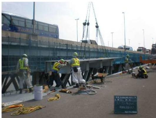
写真-21 I 橋床版拡幅工事
