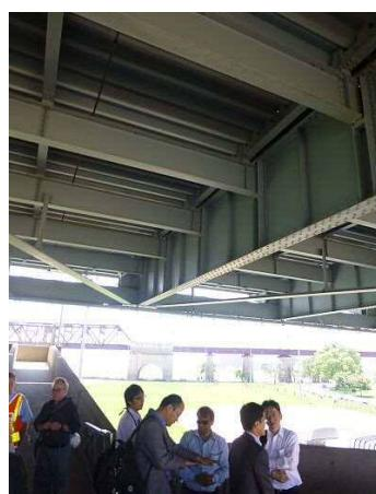
写真-36 Bronx トラス橋の鋼床版取り替え
