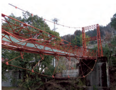
写真-12 下流側より左岸側を撮影
