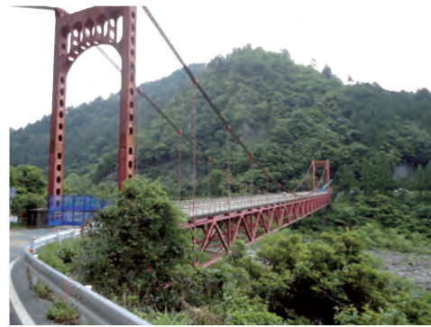
写真-1 原田橋外観図（右岸側）
