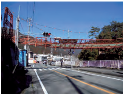
写真-11 下流側から撮影
