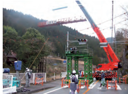
写真-16 主構の撤去
