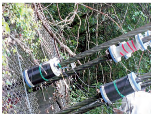
写真-5 全磁束法の設置状況
