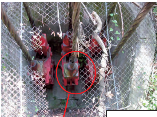
6本中4本が完全破断
