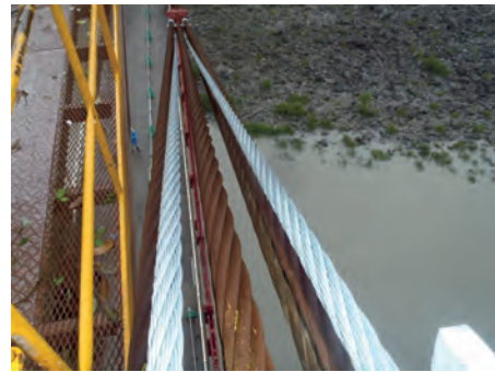
写真-8 新旧ケーブルの交差状況
