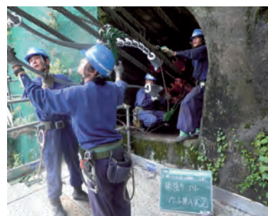
写真-10 ケーブルの引き込み状況
