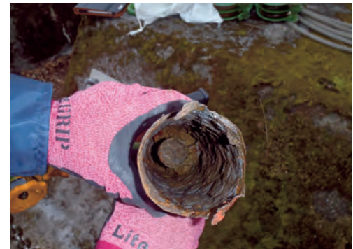
写真-14 破断した下流側
