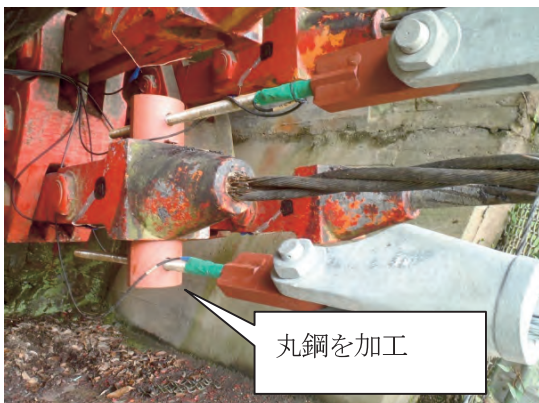
写真-7 ロッド定着構造
