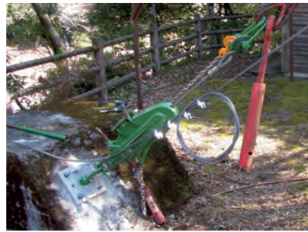
写真-15 引き込み装置の設置
