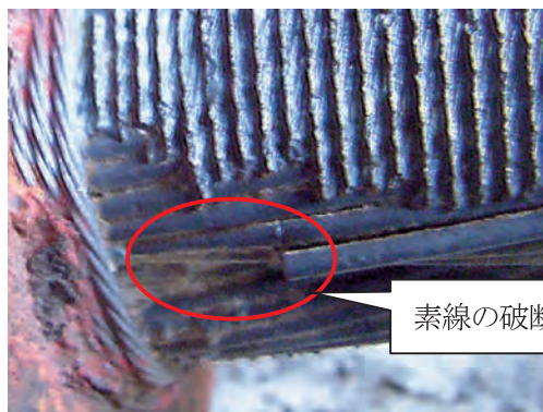
写真-4 上流側の素線の破断状況
