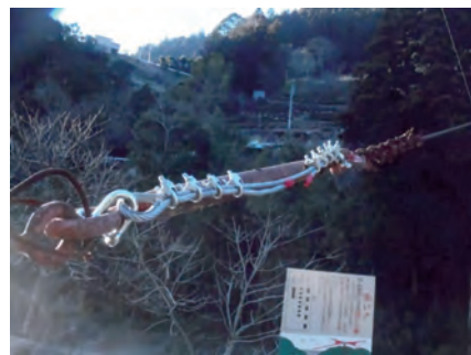
写真-17 補助ワイヤーの設置
