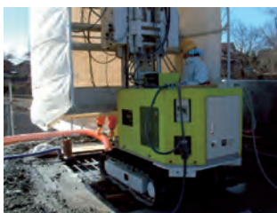
写真-7 ウォーター ジェットロボット
