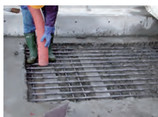
写真-8 ウォーター ジェットによるはつり後
