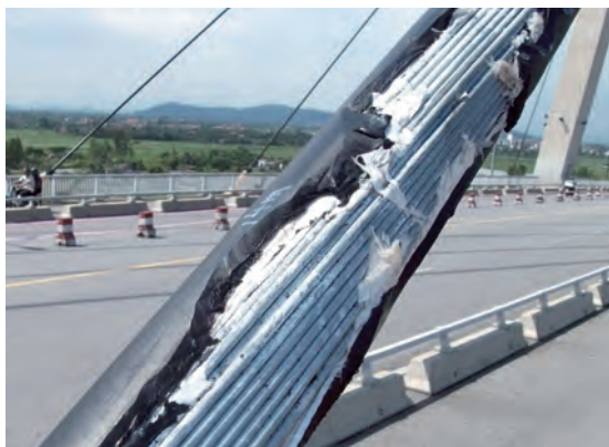
写真-5 ケーブル損傷状況
