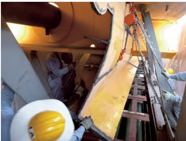
写真-10 桁切断の状況
