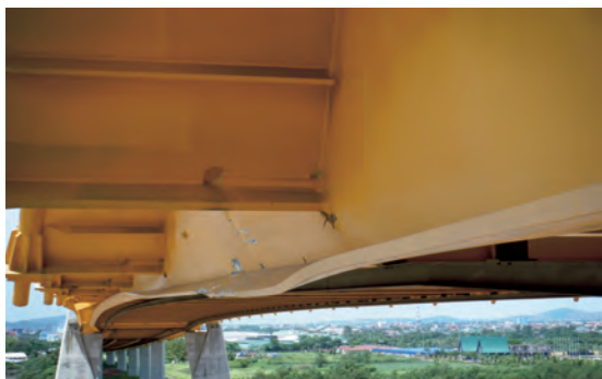
写真-3 主桁外側損傷状況
