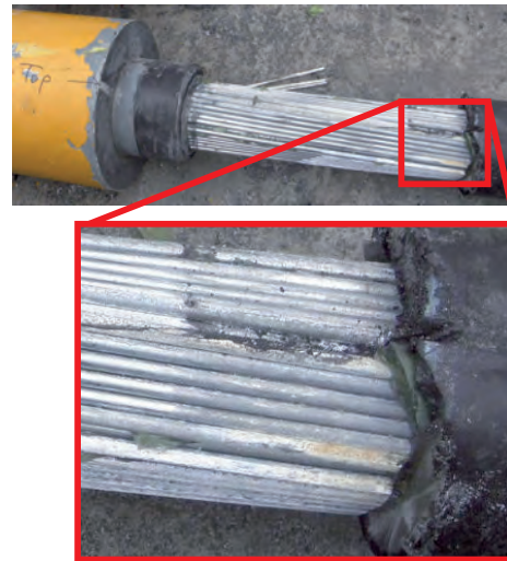
写真-14 ケーブル開放調査の様子がある。
