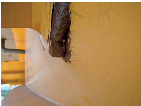
写真-6 腹板のき裂
