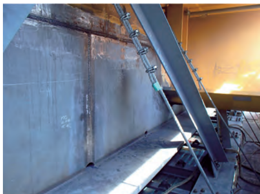
写真-12 主桁部材の取付け・溶接の状況
