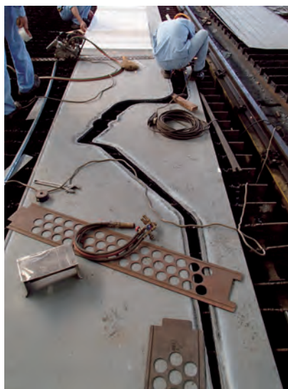
写真-11 主桁部材工場製作の状況
