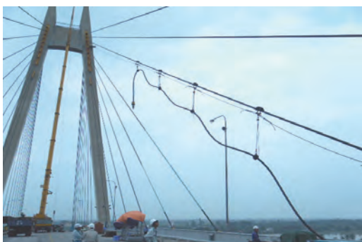
写真-13 ケーブル撤去
