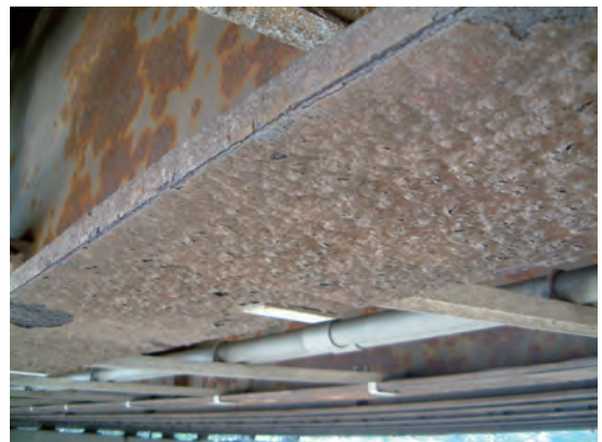
写真-3.1 飛来塩分による損傷事例
