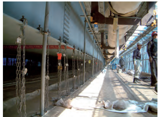
写真-3.2 補修塗装事例
