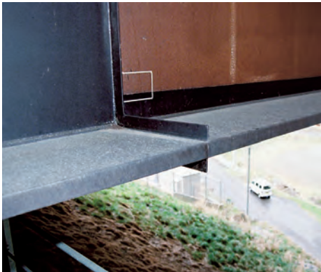
写真-3.18 水切り板設置例
