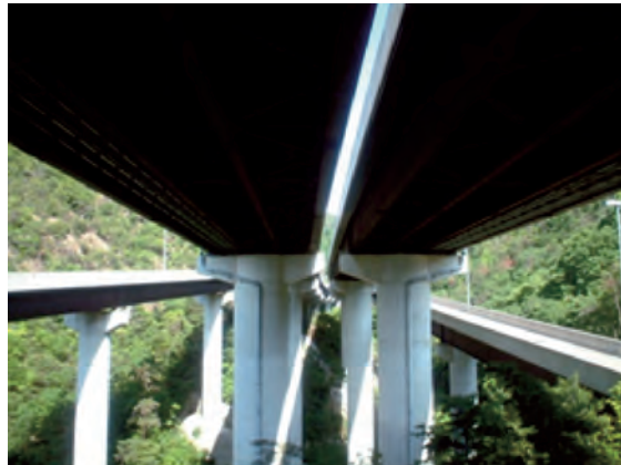
写真-3.5 凍結防止剤散布路線の並列橋
