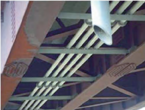
写真-3.12 排水流末からの飛散で腐食した例
