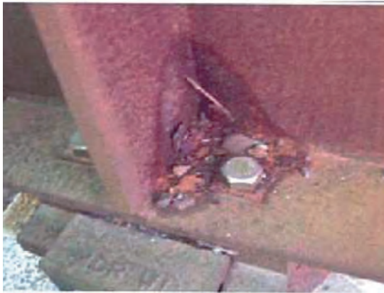
写真-3.16 支点上滞水事例
