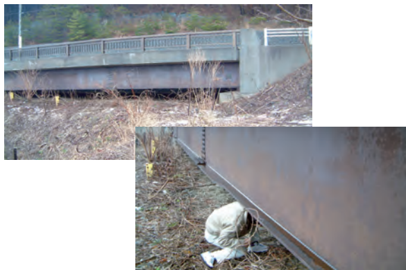
写真-3.4 閉塞的空間事例（桁下空間不足）
