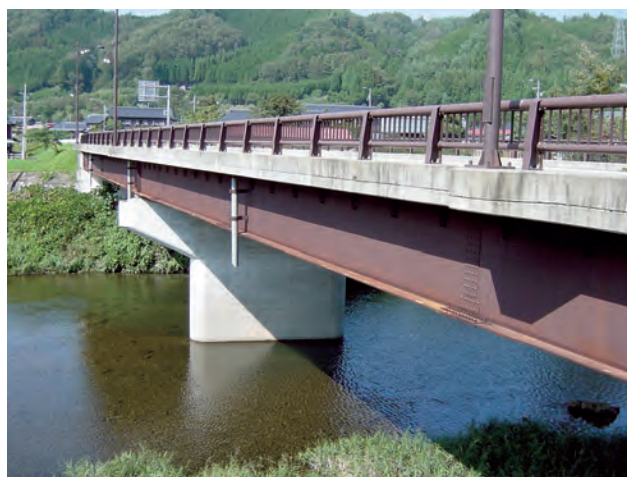
写真-4.2 床版水抜き管の流末の処理例
