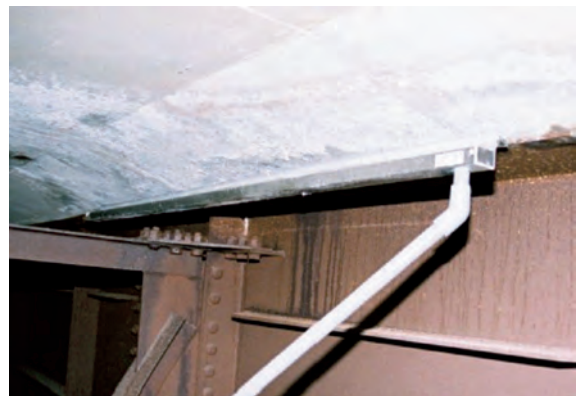
写真-3.11 床版漏水の補修事例
