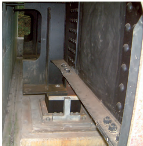
写真-3.9 桁端補修塗装事例
