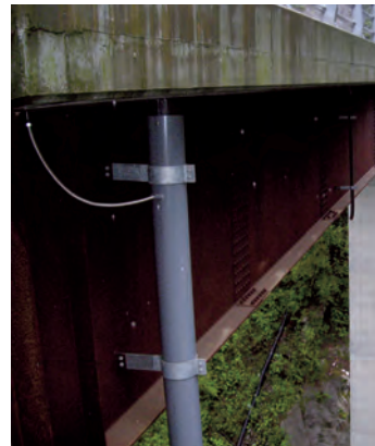
写真-3.15 床版水抜き管を排水管へ導水した例
