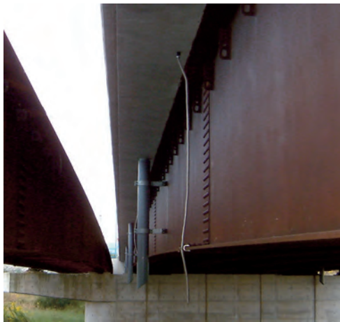
写真-3.13 排水管流末を桁下まで十分延ばした例
