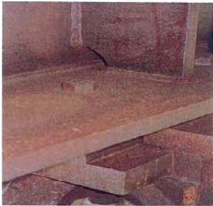
写真-3.17 支点上補剛材スカーラップ設置例
