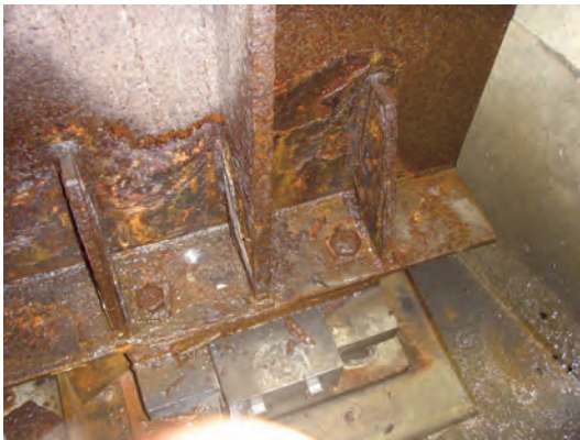
写真-3.7 伸縮装置からの漏水による腐食
