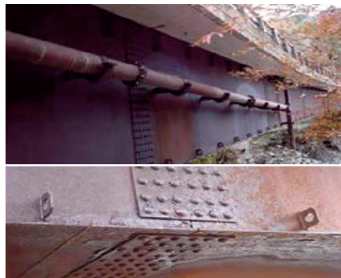
写真-3.10 床版からの漏水による腐食
