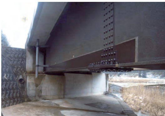
写真-3.8 部分的な補修塗装事例
