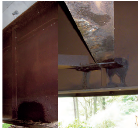
写真-3.14 床版水抜き管の排水で腐食した例
