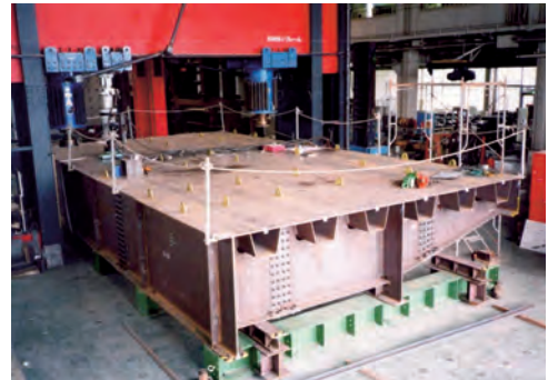
写真-5 JHによる合理化鋼床版の実験
