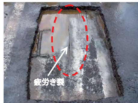
写真-18 デッキ貫通き裂
