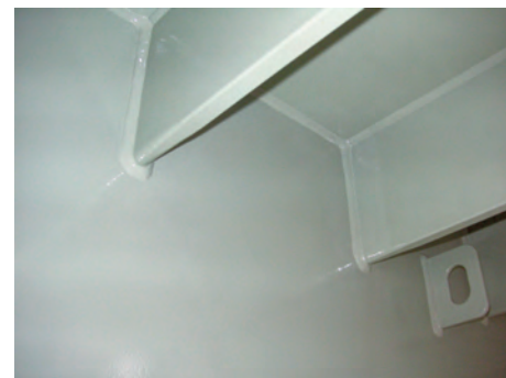
写真-28 縦リブ横リブ交差部のスリット構造
