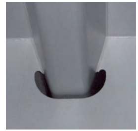
図-25 縦リブ横リブ交差部構造
