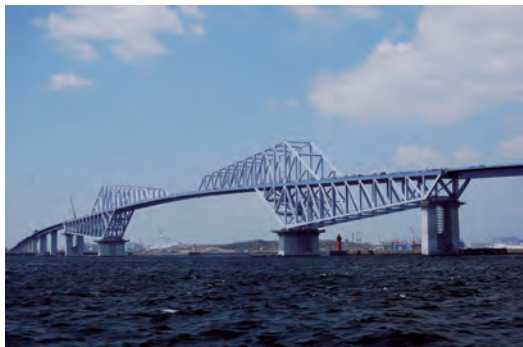
写真-23 東京ゲートブリッジ
