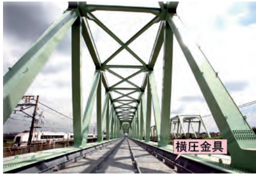
写真-29 鋼床版上面の横圧金具
