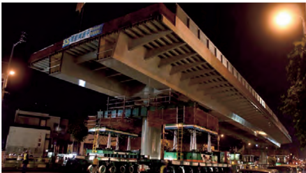
写真-3 小坂高架橋の一括架設
