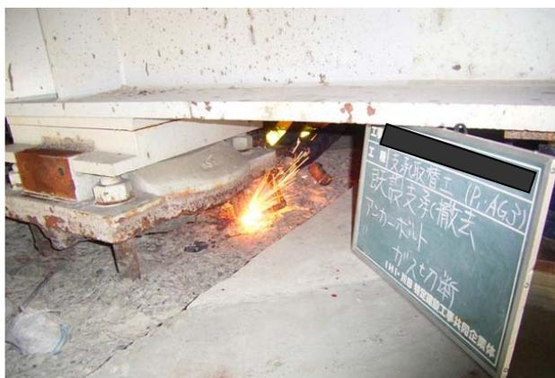
写真 - 56 アンカーボルト切断
