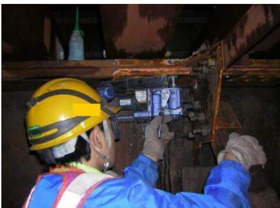
写真-29 小型の孔明け機械
