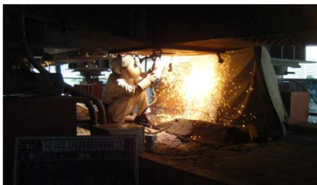
写真 - 57 溶接ビードのガウジングによる撤去
