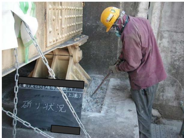
写真 - 55 沓座モルタルのはつり
