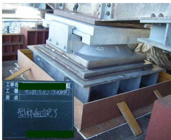
写真-59 沓座モルタル用型枠設置
