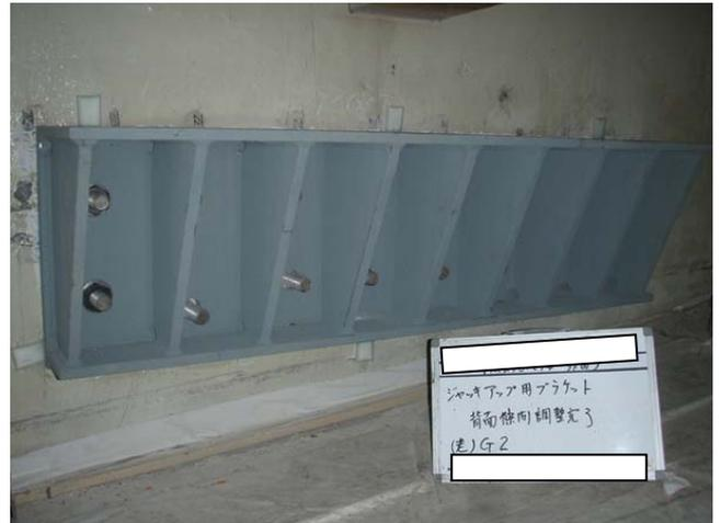
写真-13 ジャッキアップブラケット取付状況
