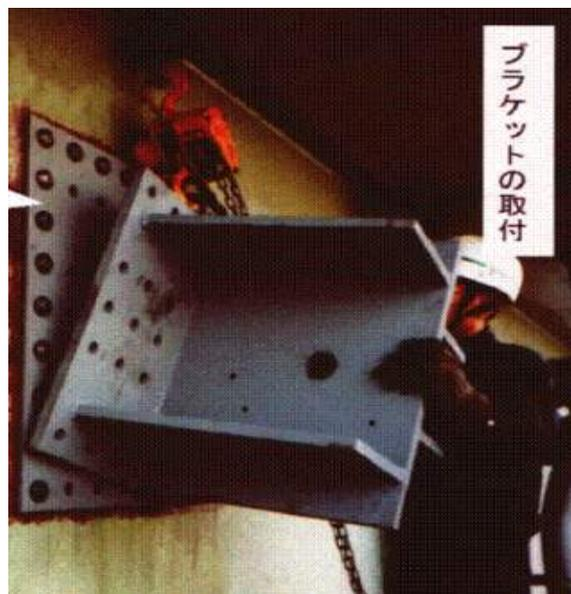
写真-32 鋼桁への部材取付
