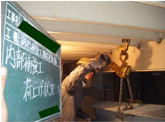
写真-33 箱桁内部への部材取付
