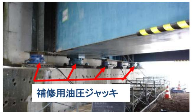
写真 - 44 補修用油圧ジャッキ使用状況 (1)
