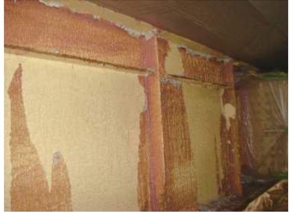
写真-26 インバイロワンによる塗膜軟化
