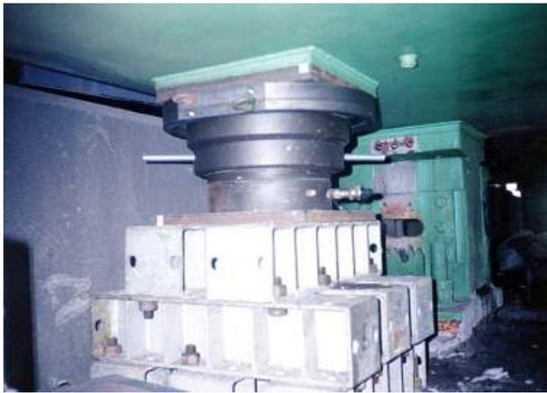
写真 - 45 補修用油圧ジャッキ使用状況 (2)
