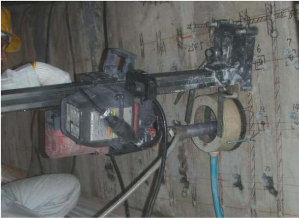
写真-9 ダイヤモンドコアドリルによる本削孔
