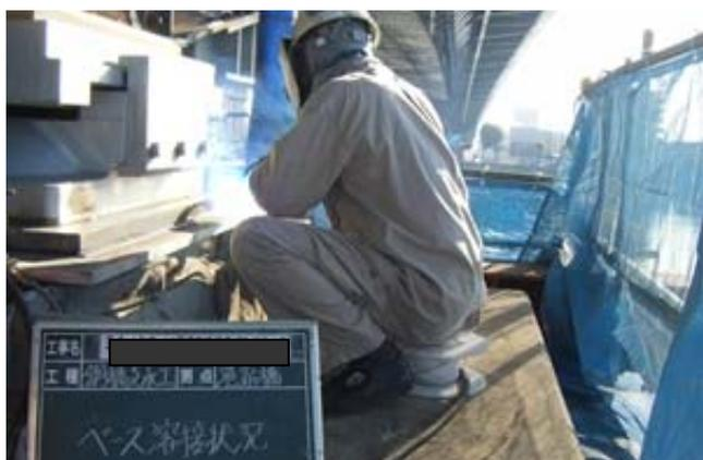
写真 - 58 新設支承の現場溶接
