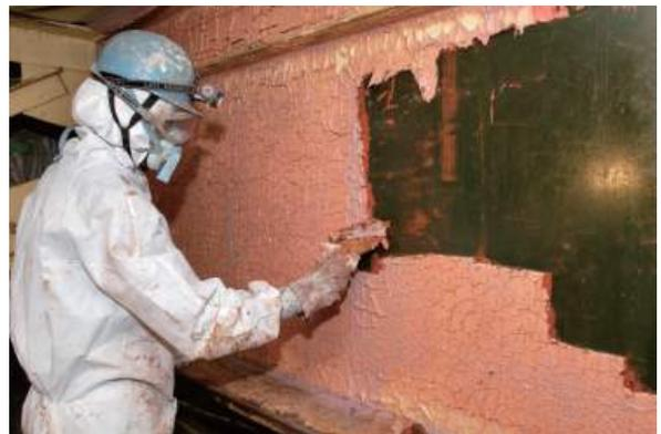
写真-27 インバイロワンによるシート状剥離
