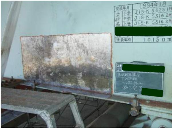
写真-18 ディスクグラインダーによる処理完了
