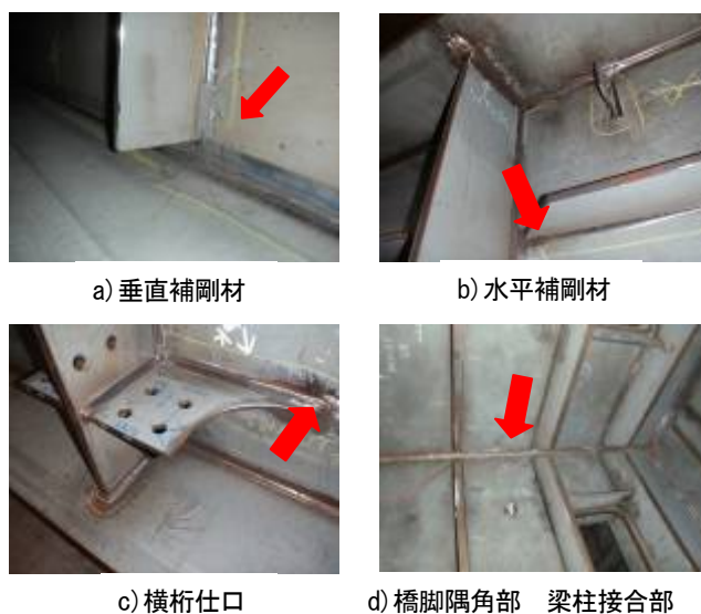
写真-1 適用継手事例
