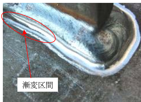
写真-3 止端仕上げの漸変区間施工例
