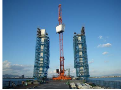
写真-5 主塔架設
