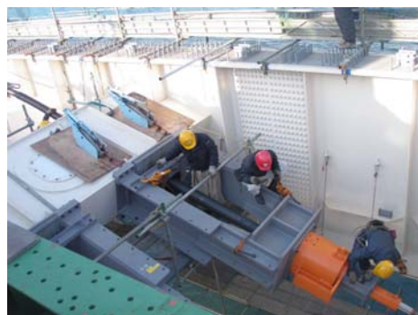
写真-8 バックステイケーブル定着
