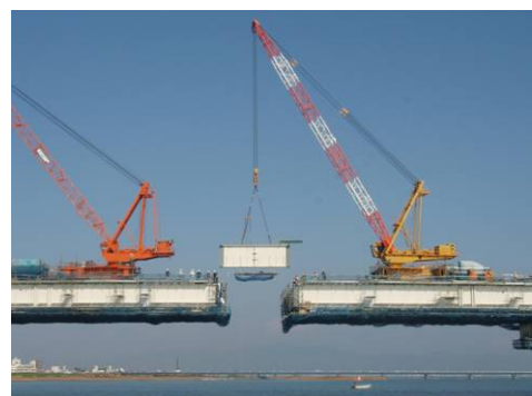
写真-7 閉合桁架設
