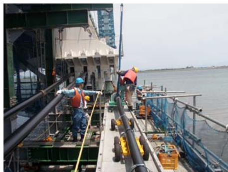
写真－9 水平ケーブル展開・架設
