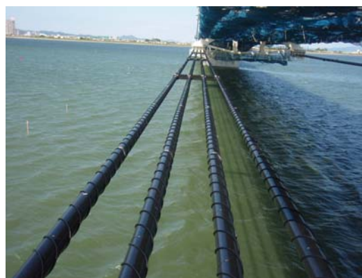
写真-18 水平ケーブルの制振対策
