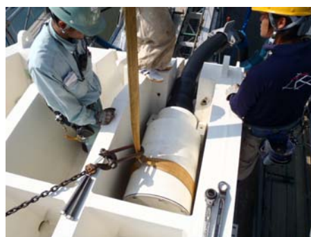
写真－11 斜ケーブル主塔側定
