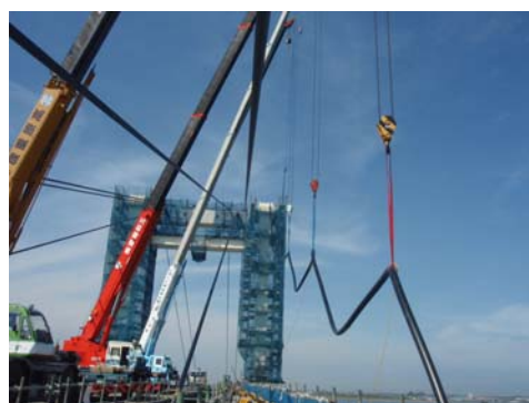
写真－12 本ケーブル架設
