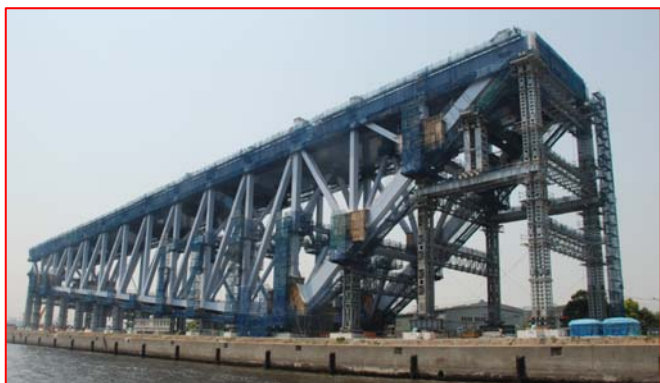
写真－5 地組立完了（有明ヤード：中央防波堤側ブロック）
