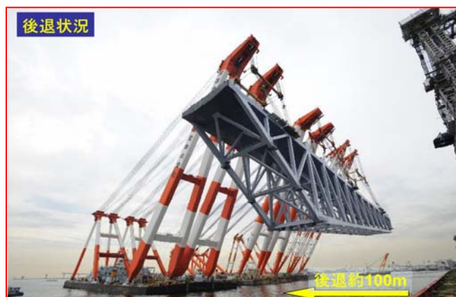
写真－8 浜出し状況（後退）
