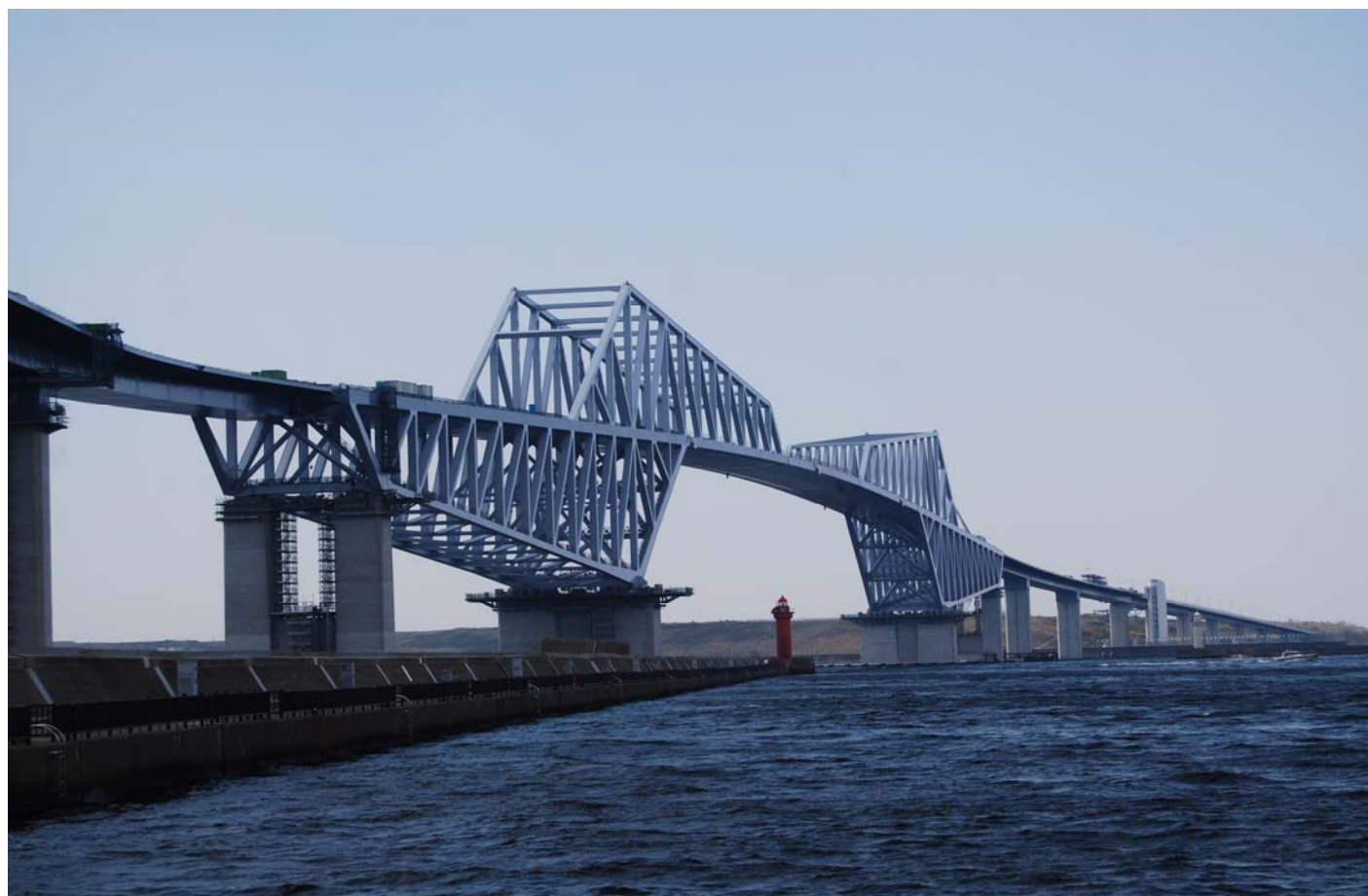
写真-25 東京ゲートブリッジ 全景写真
