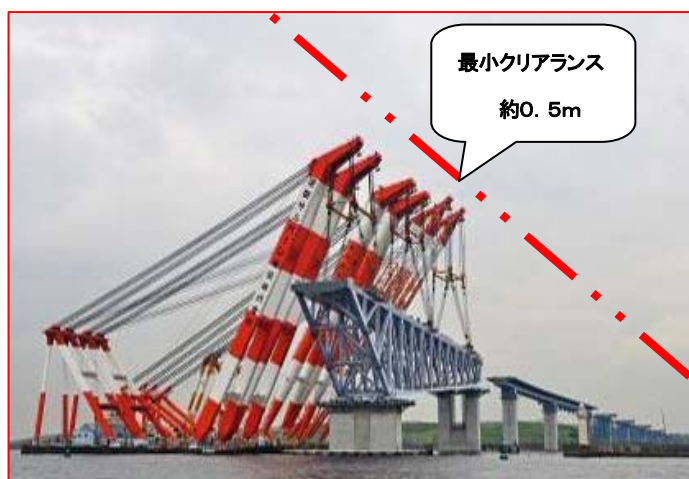
写真-21 架設地点高度制限高さ
