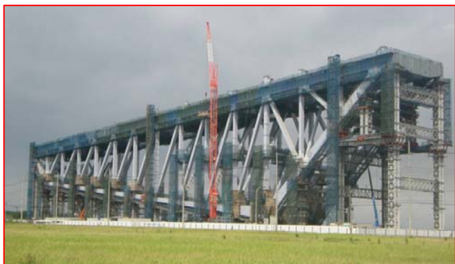
写真－6 地組立完了（富津ヤード：若洲側ブロック）
