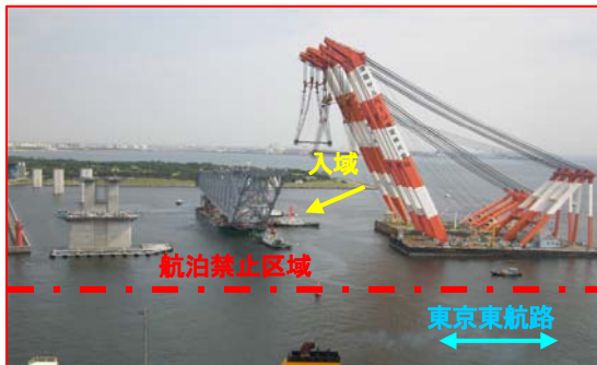
写真－12 海上輸送状況（架設地点入域）
