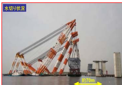
写真－13 架設状況（水切り）
