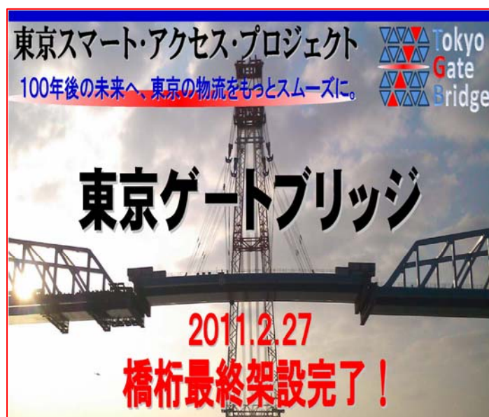
写真-24 東京ゲートブリッジ橋桁最終架設完了
