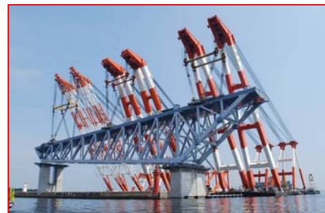
写真－17 若洲側架設
