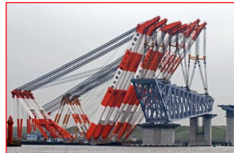
写真－16 中央防波堤側架設
