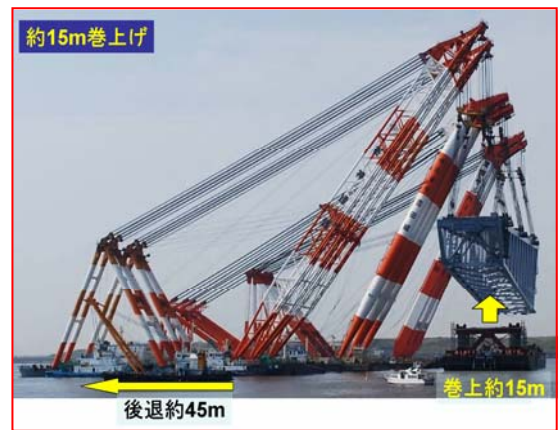
写真－14 架設状況（巻上げ）
