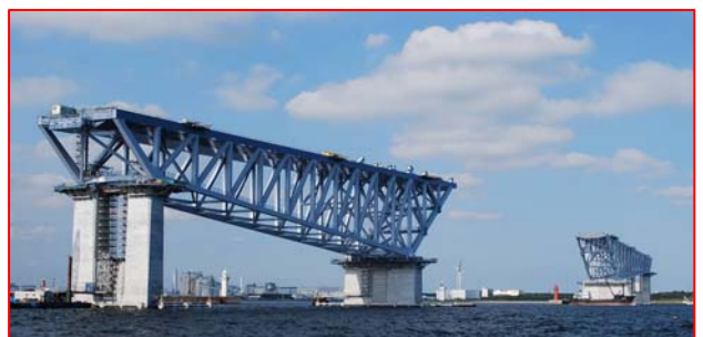
写真－18 架設完了
