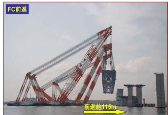
写真－15 架設状況（前進）
