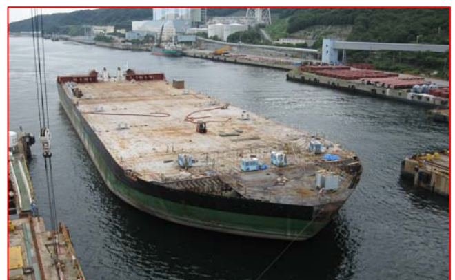
写真-4 台船改造(切断撤去)完了
