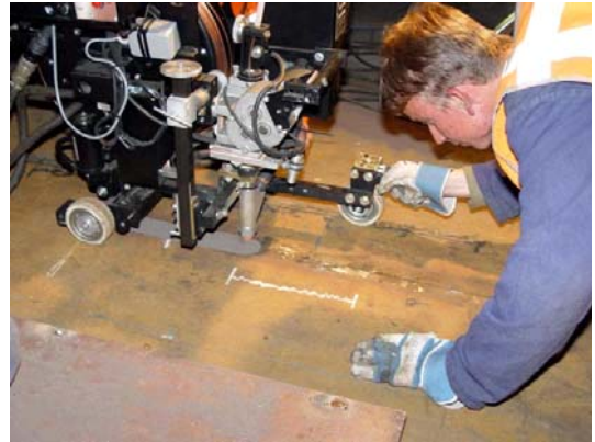
図-25 サブマージアーク溶接状況 23)
