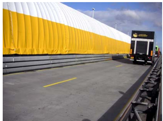
図-28 HPRC 舗装の完成 (供用開始)
