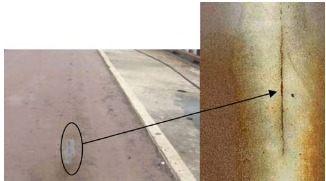
図-11 中国におけるデッキ貫通き裂 13)
