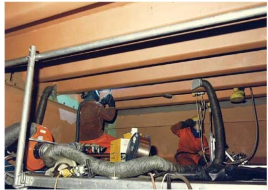
図-29 補修溶接の様子 15)
