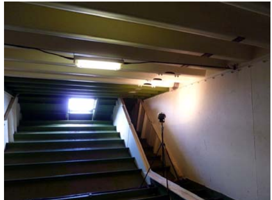
図-34 Severn橋の箱桁内部の様子
