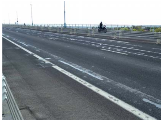
図-33 Severn橋の舗装の状況
