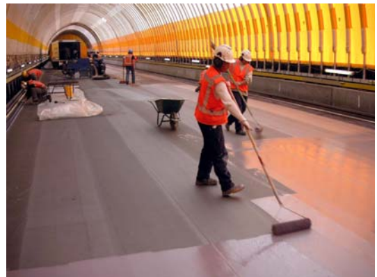
図-26 金属プライマーの塗布
