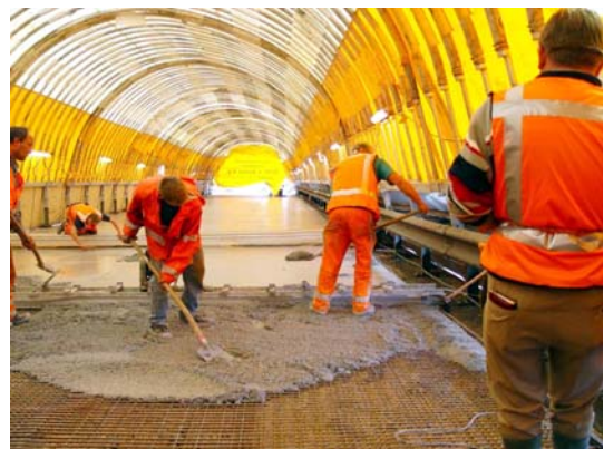
図-27 HPRC の打設状況 23)
