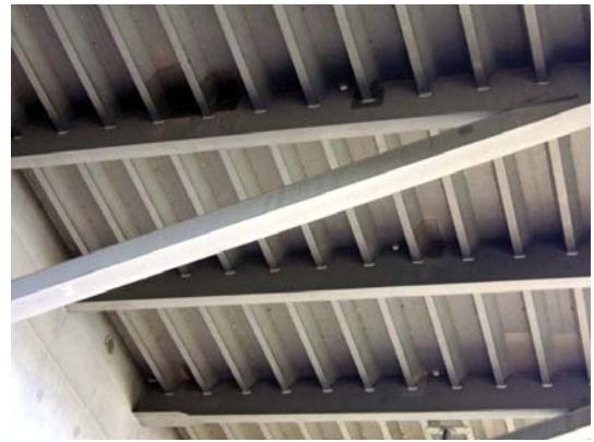
図-21 B 橋の鋼床版
