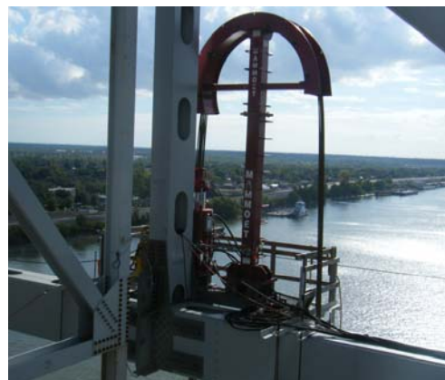
写真-29 310t吊りストランドジャッキ(降下用)
