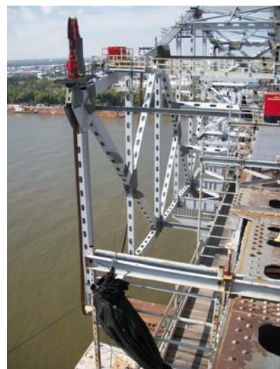
写真-25 吊上げ（サスペンデッドスパン）
