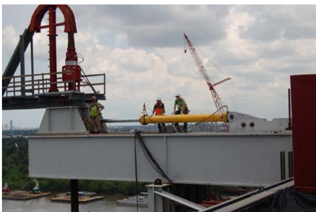
写真-26 支点部横移動機構
