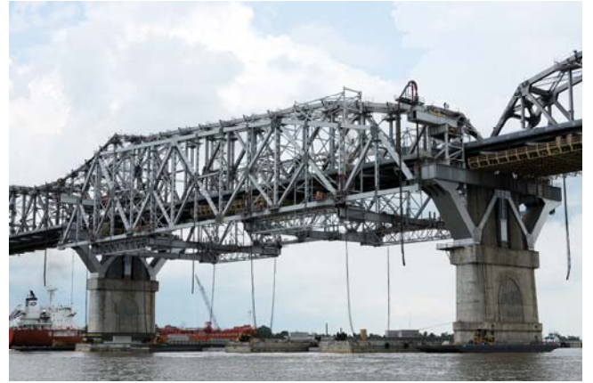
写真-32 大ブロック吊上げ状況(アンカースパン)
