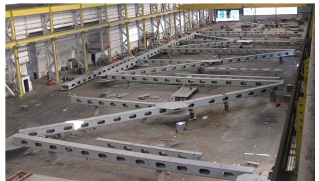
写真-7 上弦材仮組立
