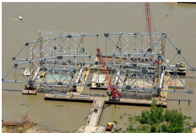
写真-22 水上地組立（閉合前）
