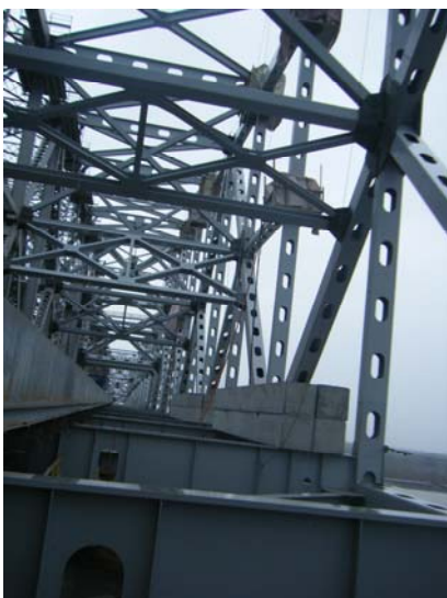
写真-4 模擬荷重によるキャンバー調整
