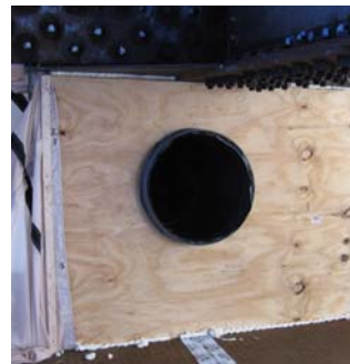
写真-12 剥離塗料回収管
