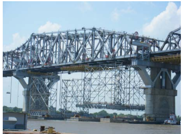
写真-34 スタビリティフレーム降下状況(アンカースパン)
