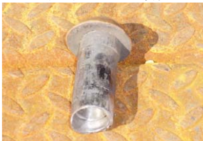
写真-10 除去後リベット
