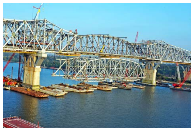
写真-20 第2回大ブロック架設 (サスペンデッドスパン吊上げ)
