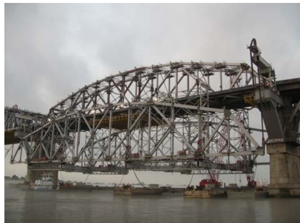
写真-19 第3回大ブロック架設 (単径間吊上げ)
