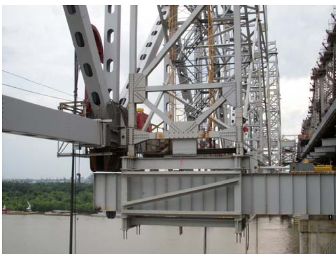
写真-27 スタビリティフレーム横移動機構
