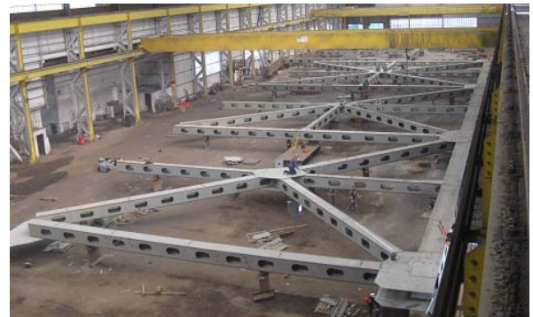
写真-6 下弦材仮組立
