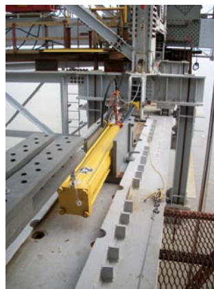
写真-28 スタビリティフレーム上摺動機構
