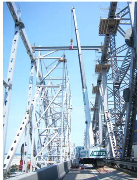
写真-33 仮設横構設置状況(アンカースパン)
