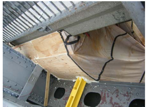
写真-11 粉塵飛散防止設備
