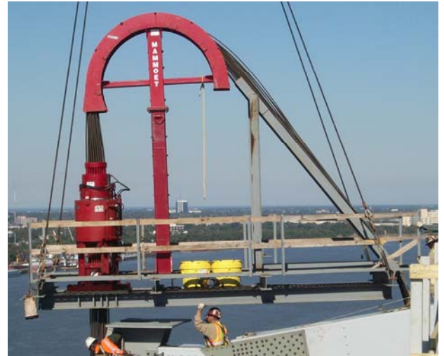
写真-23 900 t ストランドジャッキ
