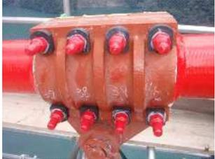
【ボルト取替状況】                      【ボルトキャップ取付状況】
