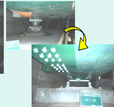
端支点支承の取り替え
