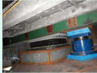
台座及び免震支承設置完了
