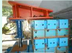
ジャッキアップ設備
