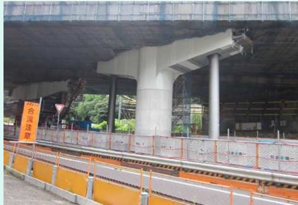
新設橋脚完成
