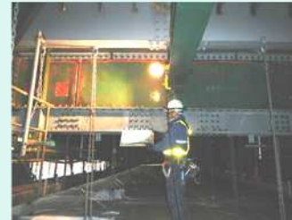
横桁補強工
