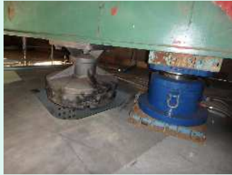
免震支承設置前
