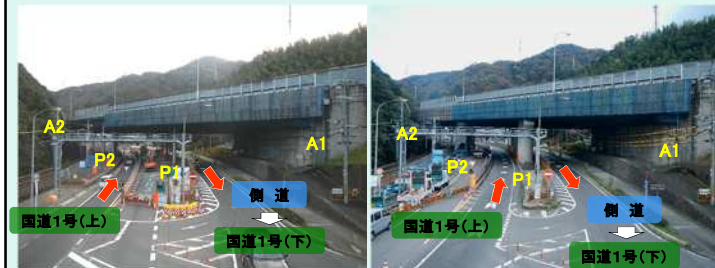
P1橋脚施工時の状況
