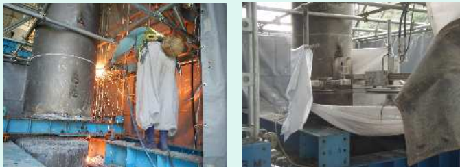
ガス切断状況
