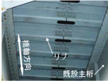
橋軸直角方向に配置した例
