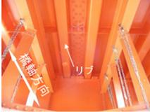
橋軸方向に配置した例
