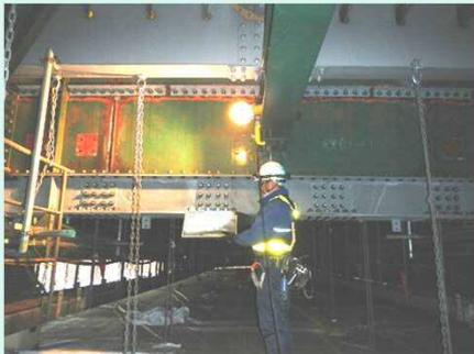
横桁補強工
