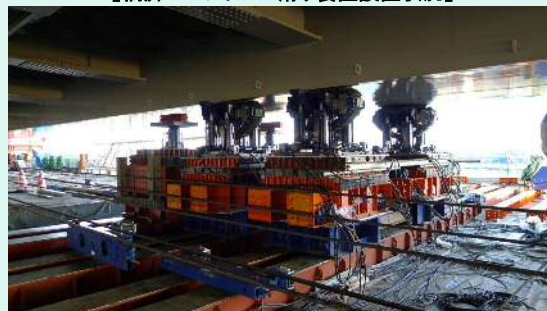
【橋脚上エンドレス滑り装置設置状況】
