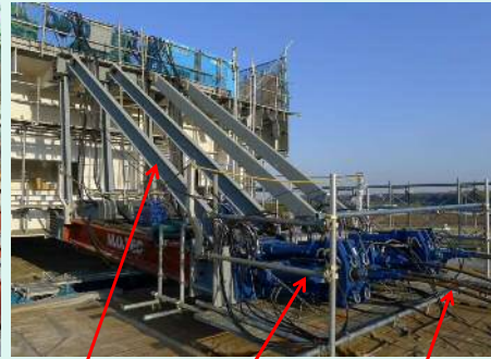
【ダブルツインジャッキ設置(1セット×2使用)】
