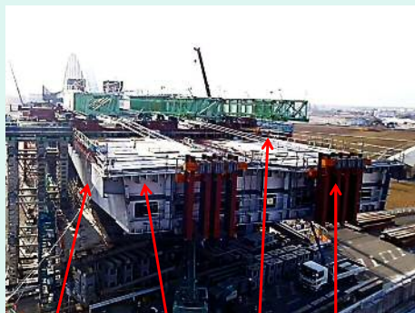
鋼桁ブロック
