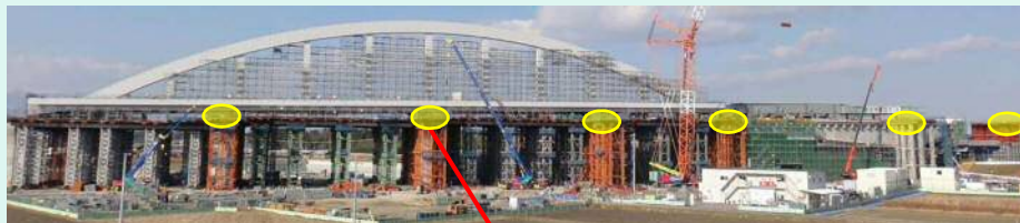
P6橋脚 P5橋脚 P4橋脚 P3橋脚 P2橋脚 BT2
