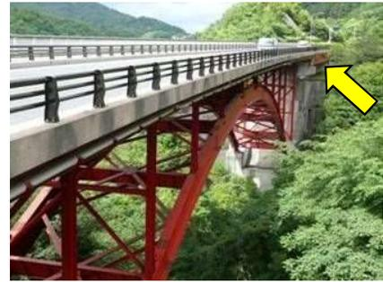
塗膜の「剥がれ」が著しい。塗装後18年を経過した時点でポリウレタン樹脂塗装系で塗り替えられました。
