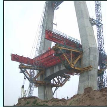
主桁、横桁架設
