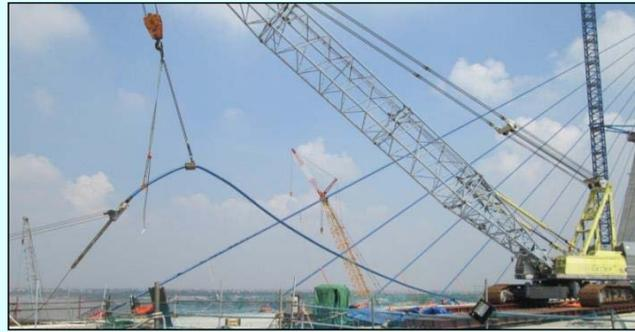
スティケーブルの架設(桁側)
