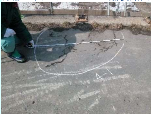
実橋調査結果=劣化 試験体No.4-1
