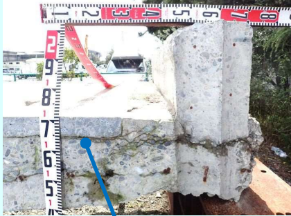
②舗装と地覆の継目(水みち)
