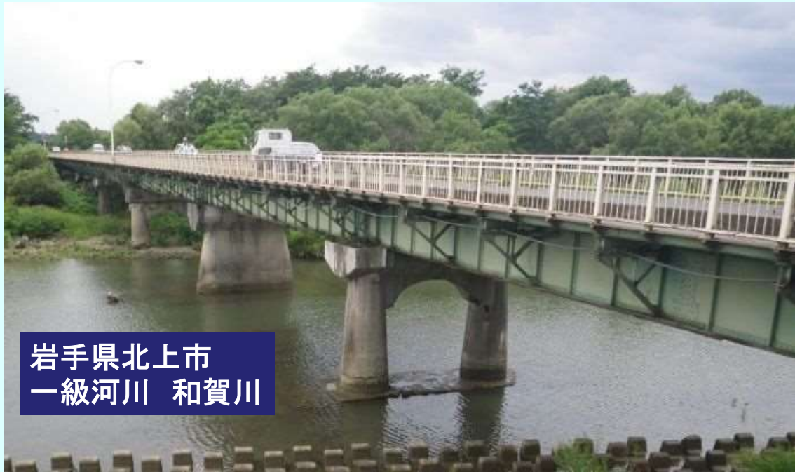
写真 九年橋(大規模修繕工事前)
