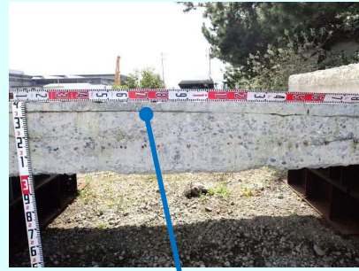
④床版と舗装の境目での剥離
