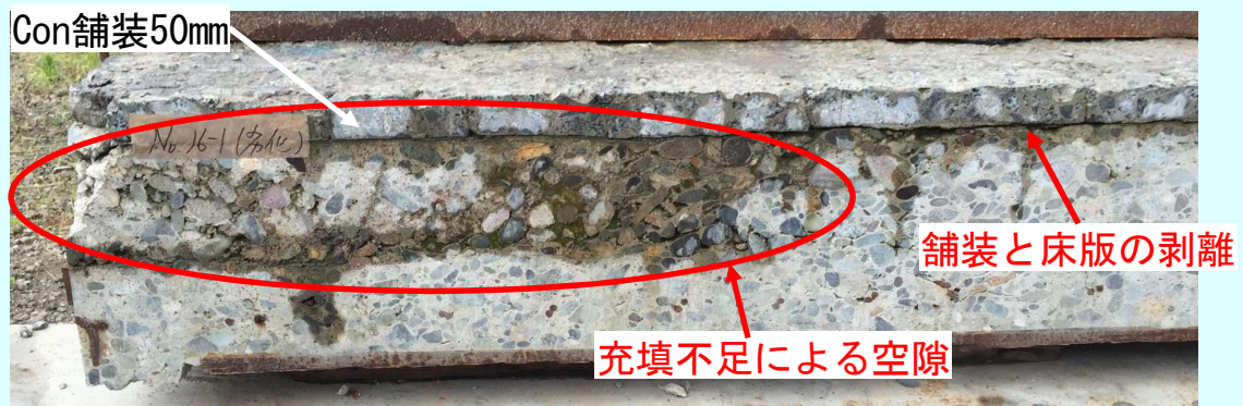
写真 4 主鉄桁の撤去床版
