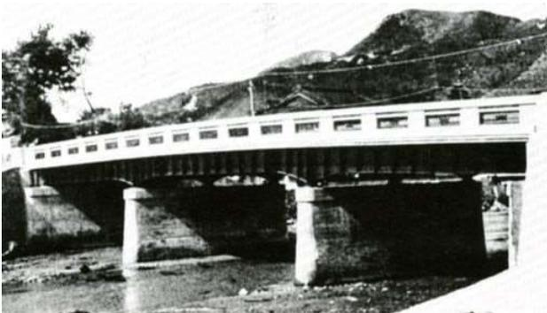
初の完全溶込み溶接継手を取り入れた
