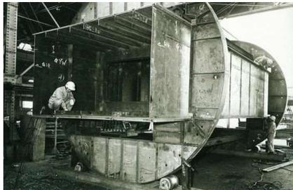
ブロック反転ができなかったため、回転枠により反転させている
